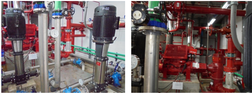
ภาพที่ 3-30 ห้องเครื่องปั๊มน้ำและห้องเครื่องปั๊มน้ำดับเพลิง
