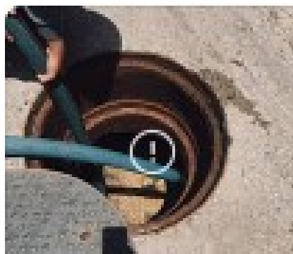
ภาพที่ 3-8 การสูบล้างตะกอนจากบ่อบำบัดตะกอน
