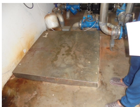
ภาพที่ 3-15 ถังสำรองน้ำใต้ดินและฝาทังสำรองน้ำ
