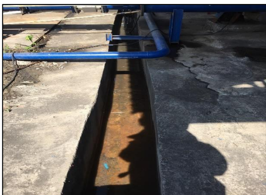
ภาพที่ 15 รางระบายน้ำล้างสารกรอง ของระบบผลิตน้ำใสของโครงการ
