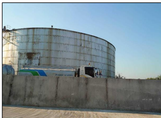
ภาพที่ 20 คันคอนกรีตป้องกันกากน้ำตาลที่อาจรั่วไหลออกจากถังเก็บกากน้ำตาล
