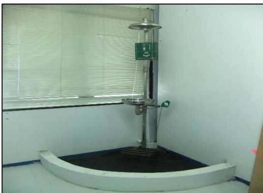
ภาพที่ 62 การจัดให้มีฝักบัวฉุกเฉิน และอ่างล้างตา
