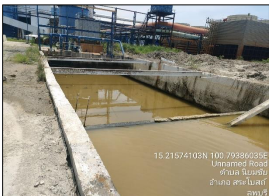
ภาพที่ 12 บ่อรวบรวมน้ำเสียของโครงการ
