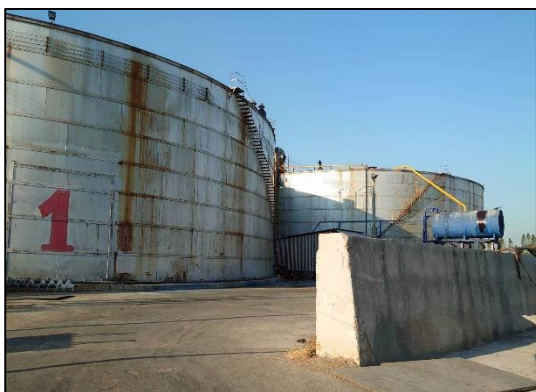
ภาพที่ 20 คันคอนกรีตป้องกันกากน้ำตาลที่อาจรั่วไหลออกจากถังเก็บกากน้ำตาล
