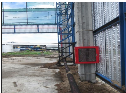
ภาพที่ 78 การติดตั้งถังดับเพลิง สายฉีดน้ำดับเพลิง และท่อน้ำดับเพลิง
