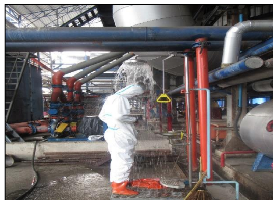
ภาพที่ 62 การจัดให้มีฝักบัวฉุกเฉิน และอ่างล้างตา
