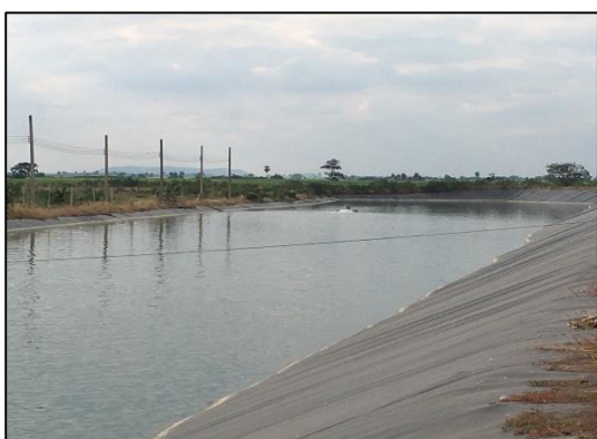
ภาพที่ 17 การปูวัสดุกันซึมด้วยแผ่นวัสดุสังเคราะห์ (HDPE) ในบ่อบำบัดน้ำเสีย
