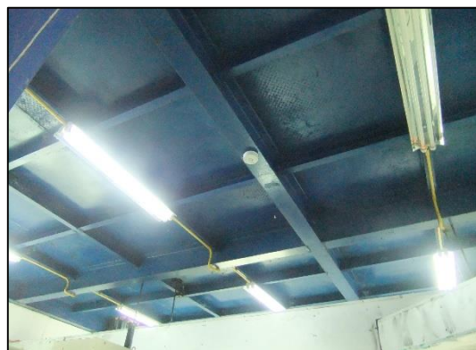
ภาพที่ 77 การติดตั้งสัญญาณแจ้งเหตุเพลิงไหม้
