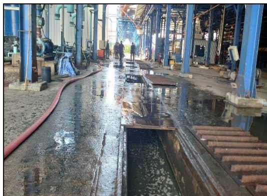
ภาพที่ 14 (ต่อ) รางระบายน้ำเสียจากการล้างพื้นและอุปกรณ์เครื่องจักรของโครงการ
