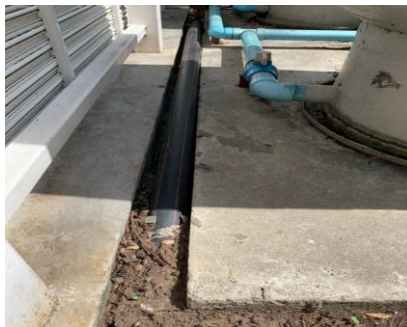
ภาพที่ 2.2-6 เส้นท่อสำหรับน้ำทิ้งไปรดต้นไม้
