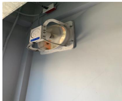
ภาพที่ 2.2-14 พัดลมระบายอากาศ
