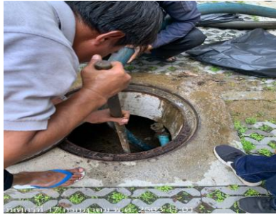
ภาพที่ 2.2-5 การสูบน้ำทิ้งก่อนระบบบำบัด
