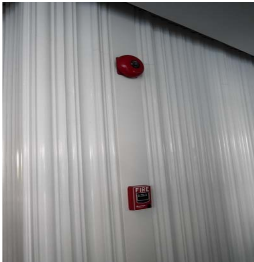
ภาพที่ 2.14 กระดิ่งส่งสัญญาณและอุปกรณ์แจ้งเหตุฉุกเฉิน
