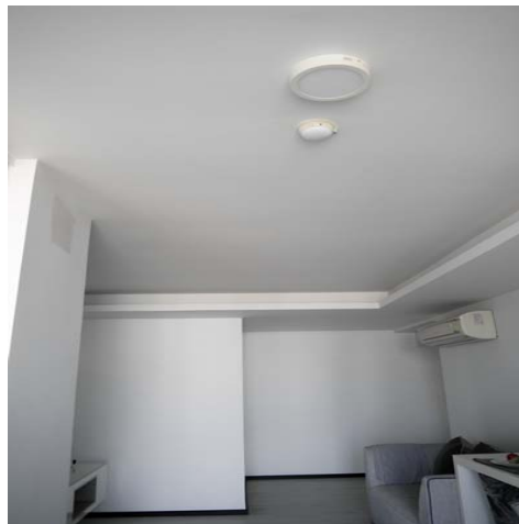
ภาพที่ 2.4 รูปเครื่องตรวจจับความร้อน เครื่องตรวจจับควัน
