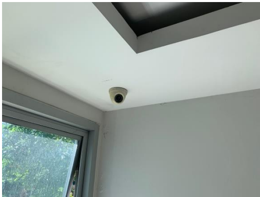
ระบบกล้องวงจรปิดควบคุมการเข้า-ออก ติดตั้งในบริเวณ โถงทางเดิน
