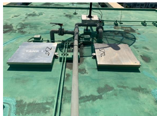
ปั๊มน้ำ และถังเก็บน้ำสำรอง ภาพที่ 1.3.4-1 (ต่อ) ระบบน้ำใช้
