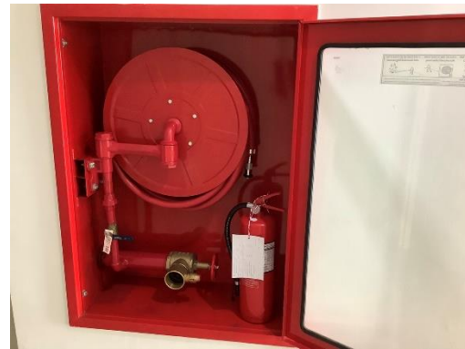
ตู้เก็บสายฉีดน้ำดับเพลิง ระบบป้องกันเพลิงไหม้
