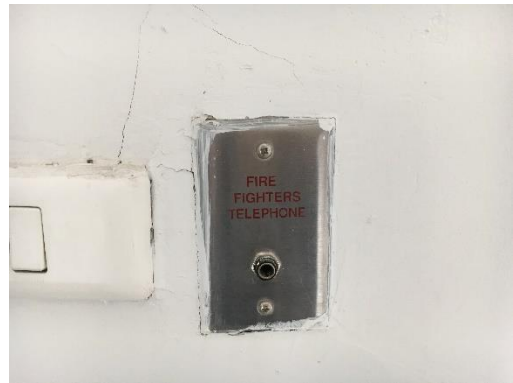
โทรศัพท์สำหรับแจ้งเหตุเพลิงไหม้
