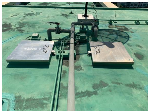
ปั๊มน้ำ และถังเก็บน้ำสำรอง ภาพที่ 2.2-9 (ต่อ) ระบบน้ำใช้
