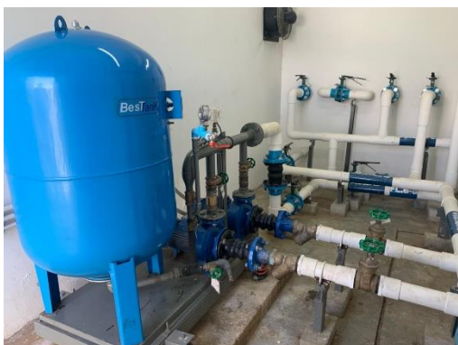
ปั๊มน้ำ และถังเก็บน้ำสำรอง ภาพที่ 1.3.4-1 (ต่อ) ระบบน้ำใช้
