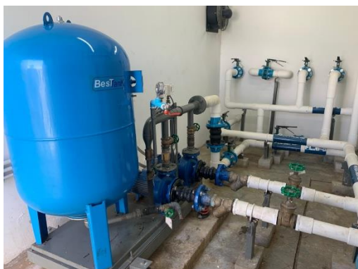
ปั๊มน้ำ และถังเก็บน้ำสำรอง ภาพที่ 2.2-9 (ต่อ) ระบบน้ำใช้
