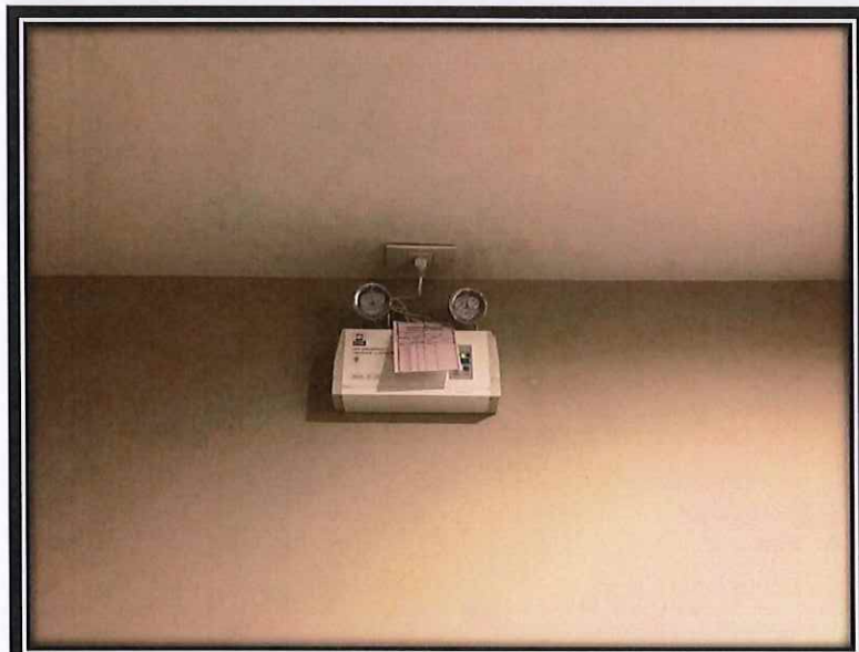
รูปที่ 2-12 อุปกรณ์ไฟฉุกเฉิน (Emergency Light)
