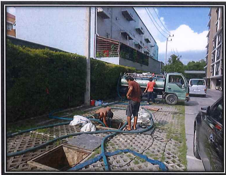
รูปที่ 2-42 สูบสิ่งปฏิกูลและล้างทำความสะอาด บ่อไขมัน/เกรอะ ประจำปี
