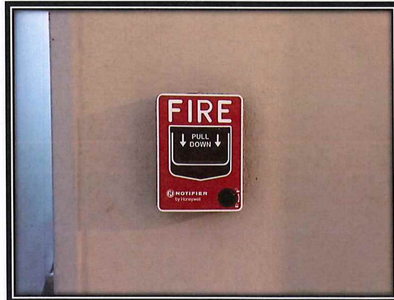
รูปที่ 2- 10 เครื่องแจ้งเหตุโดยใช้มือ (Manual Station)
