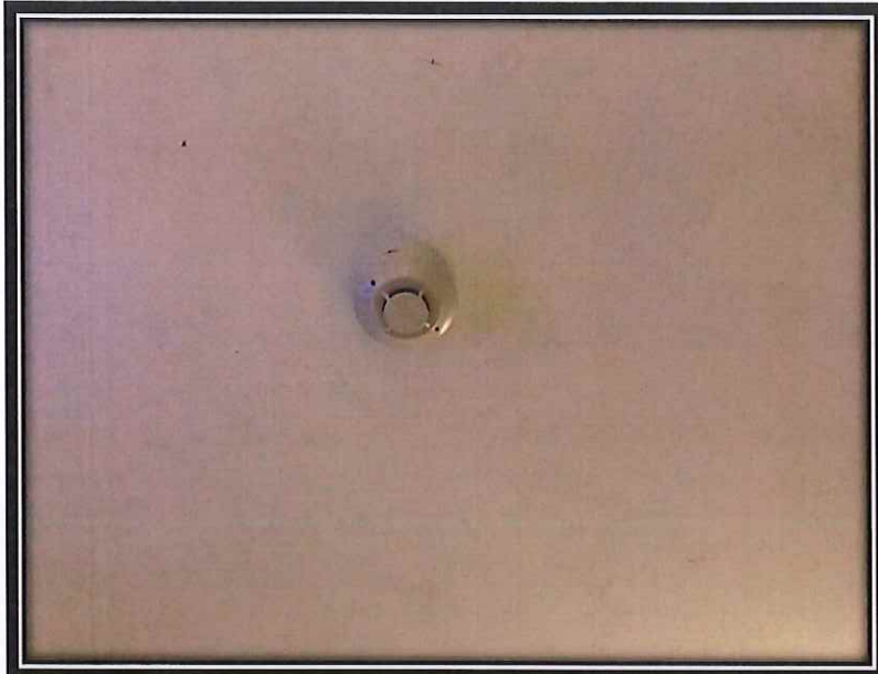
รูปที่ 2- 8 เครื่องตรวจจับควัน ( Smoke Detector)
