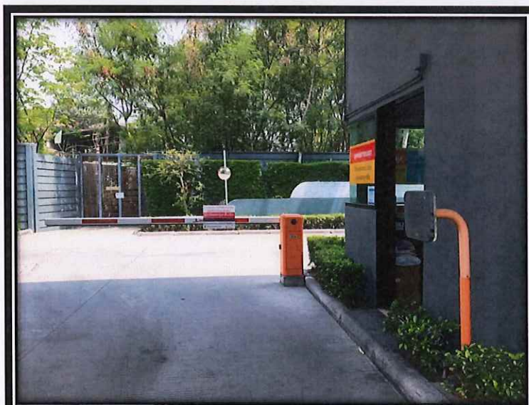
รูปที่ 2-43 ระบบบัตรอิเล็กทรอนิกส์ (Key Card) ผ่านไม้กั้นอัตโนมัติ สำหรับรถยนต์ผ่าน เข้า-ออก โครงการฯ
