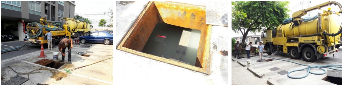
ภาพที่ 2-7 การสูบน้ำก่อนระบบบำบัดน้ำเสีย
