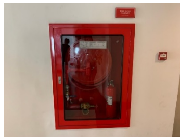
ตู้เก็บสายฉีดน้ำดับเพลิงและถังดับเพลิง
