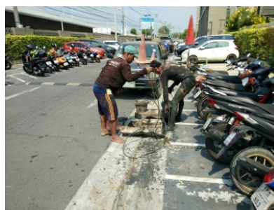
ภาพที่ 2-19 การขุดลอกตะกอนในระบบระบายน้ำ
