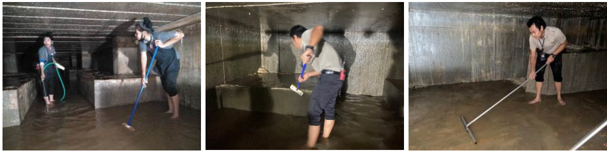
ภาพที่ 2-16 การล้างถังเก็บน้ำ
