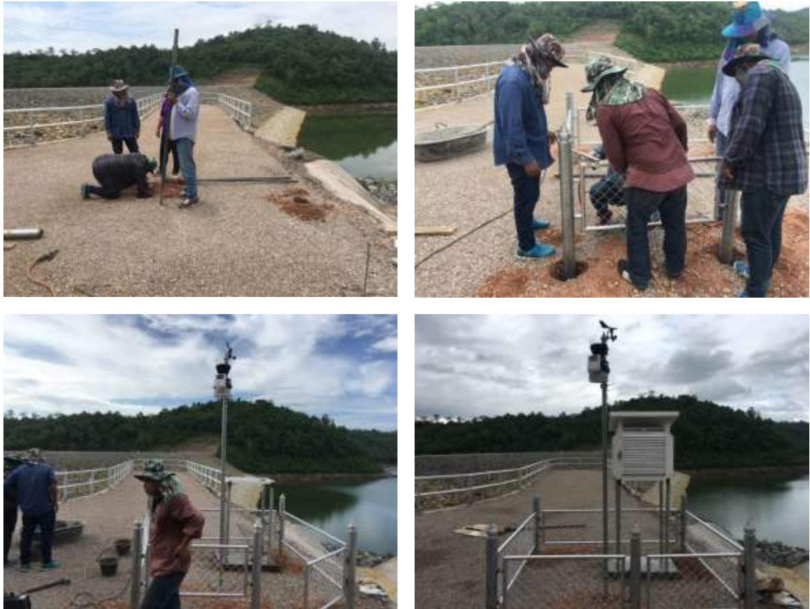
รูปที่ 5.2.1 – 5 การติดตั้งเครื่องวัดอุทุนิยมวิทยาบริเวณห้วงงานโครงการ
