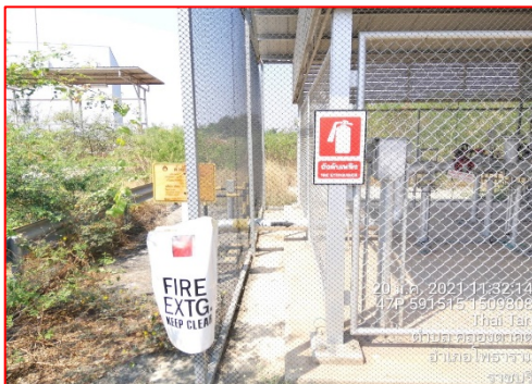
การติดตั้งถังดับเพลิงสถานีควบคุมก๊าซ
