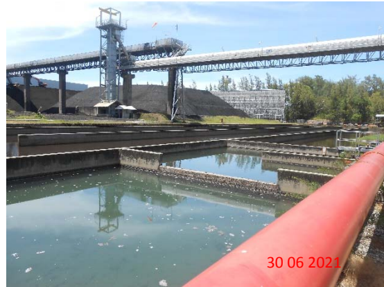
รูปที่ 6 บ่อตกตะกอน (Run off pond) สำหรับบำบัดน้ำเสียจากกิจกรรมการขนถ่ายถ่านหิน
