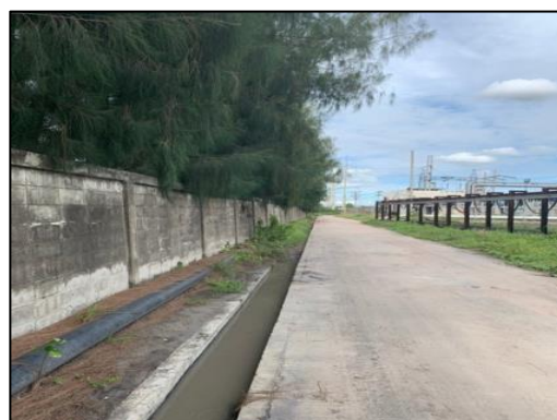
ภาพที่ 38 รางระบายน้ำฝนรอบโครงการ
