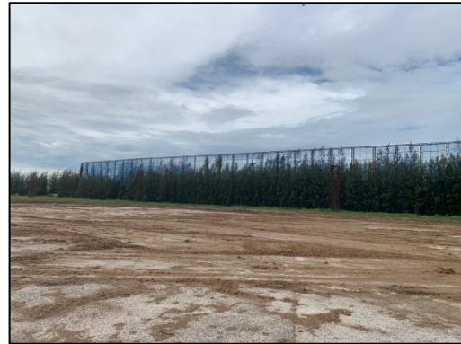
ภาพที่ 23 ติดตั้งตาข่ายสูง 35 เมตรรอบลานกองกากอ้อย
