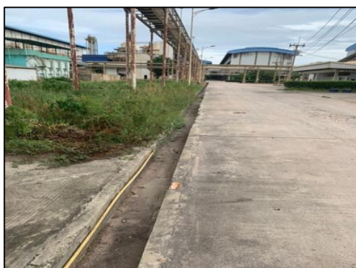
ภาพที่ 38 รางระบายน้ำฝนรอบโครงการ
