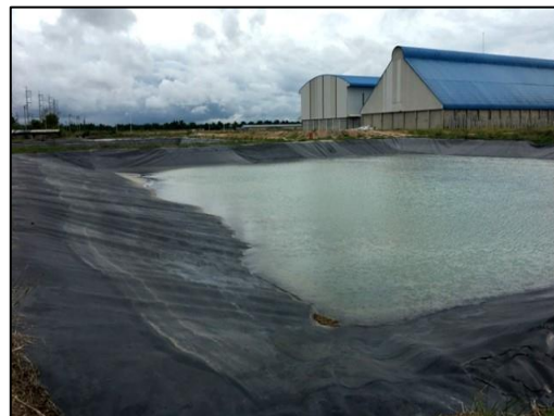
ภาพที่ 35 ระบบบำบัดน้ำเสียของโครงการ
