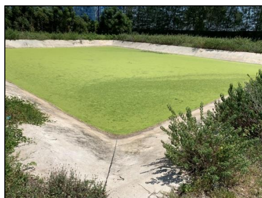
ภาพที่ 37 บ่อรวบรวมน้ำชะกองเก็บกากอ้อย
