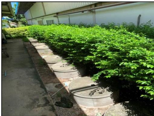
ภาพที่ 41 บ่อเกรอะ-บ่อซึม สำหรับระบบบำบัดน้ำ เสียห้อมส้วม
