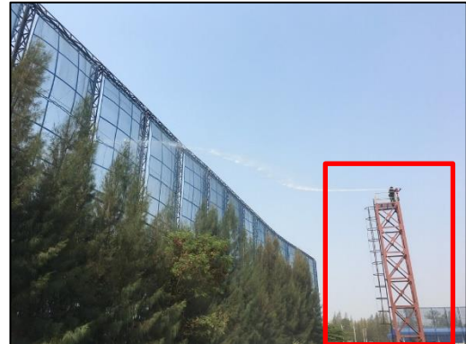
ภาพที่ 52 ระบบดับเพลิงบริเวณลานกองเก็บ เชื้อเพลิง
