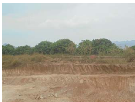
รูปที่ 2-3: คั่นทำนบดิน และการปลูกต้นไม้บนคั่นทำนบดิน
