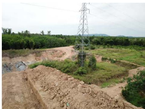
(6) แนวคันทำนบกั้นดินที่จัดสร้างเพิ่มเติม
