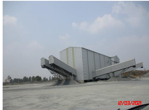
รูปที่ 2-8 อาคารปิดคลุมโรงโม่หิน 3 ด้าน
