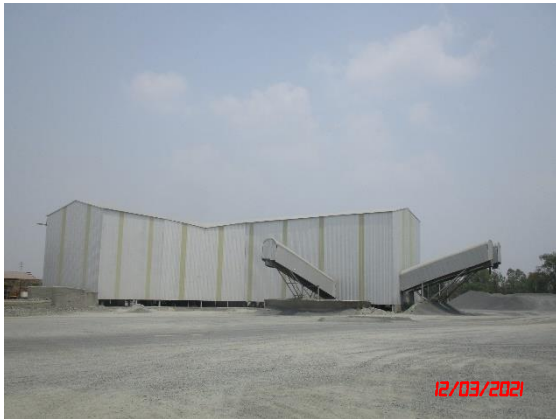
รูปที่ 2-8 อาคารปิดคลุมโรงโม่หิน 3 ด้าน
