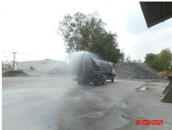
รูปที่ 2-13 การฉีดพ่นน้ำบริเวณพื้นที่โครงการ
