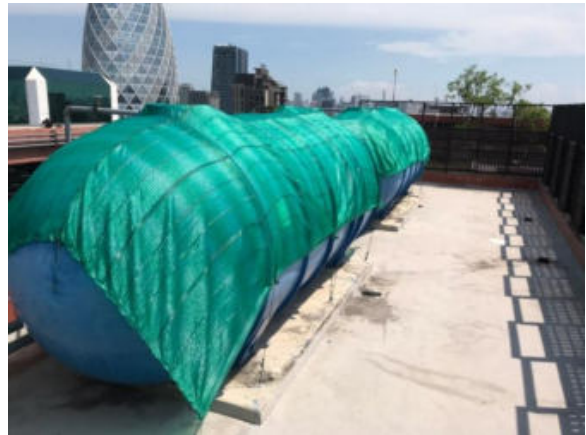
รูปที่ 2-34 ถังเก็บน้ำใช้และน้ำดับเพลิงชั้นใต้ดินดาดฟ้า
