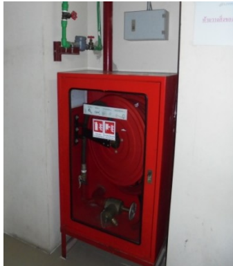
ตู้เก็บสายฉีดน้ำดับเพลิง และตู้เก็บอุปกรณ์และชุดผจญเพลิง และถังดับเพลิงเคมีมือถือ
