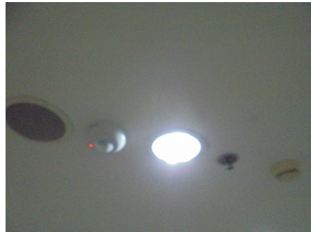
ลำโพงแจ้งเหตุเพลิงไหม้ เครื่องแจ้งเหตุโดยใช้มือดึง เครื่องตรวจจับควัน เครื่องตรวจจับความร้อน และระบบหัวกระจายน้ำอัตโนมัติ
