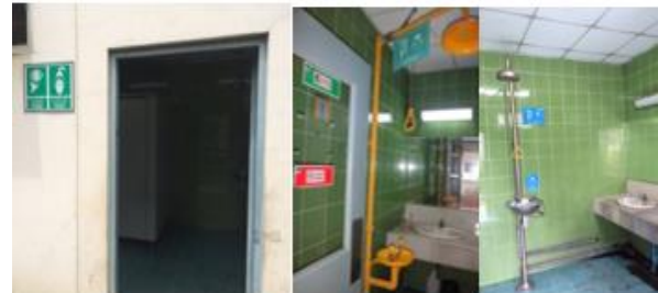
ภาพที่ 14 ฝักบัวและอ่างล้างตาฉุกเฉิน
