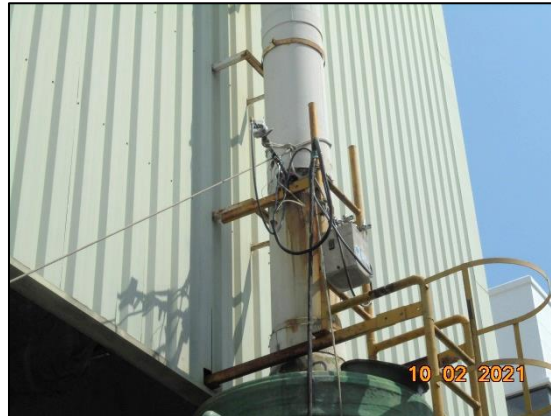
รูปที่ 3.4 การเก็บตัวอย่างคุณภาพอากาศในปล่องระบาย บริเวณ ปล่อง Wet Scrubber No.1 (เฉพาะหน่วยชุบตีบุกเท่านั้น)
