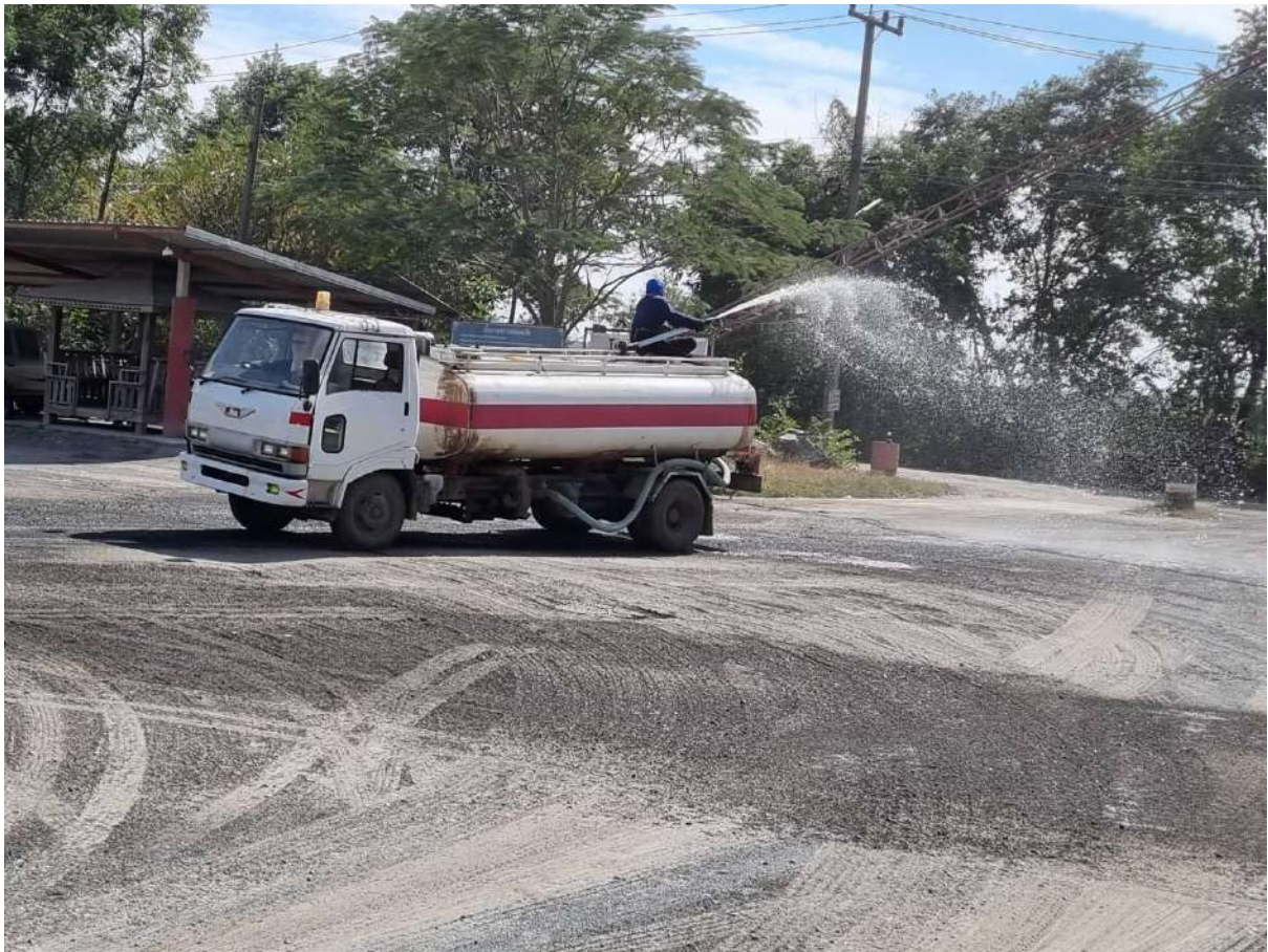
รูปที่ 7 ใช้รถน้ำ ราดน้ำ ช่วยลดผลกระทบบริเวณที่เกิดฝุ่นในโรงโม่
