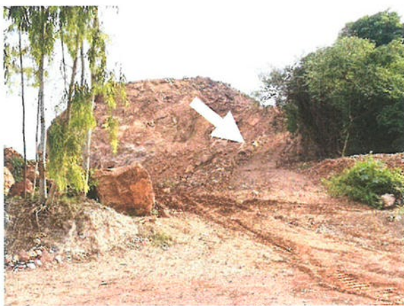
รูปที่ 2 แนวเส้นทางที่ตัดขึ้นสู่ยอดเขา เพื่อทำเหมืองจากยอดเขาลงมาสู่ด้านล่าง
