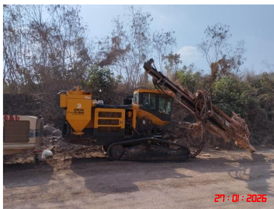
รูปที่ 21 เครื่องเจาะรูระเบิดที่มีอุปกรณ์เก็บฝุ่นติดไว้กับหัวเจาะ
