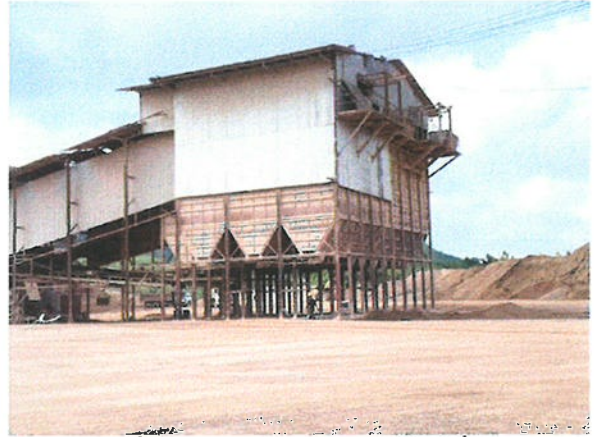
รูปที่ 16 การปิดคลุมอาคารโรงโม่หิน ชุด Product Screen
