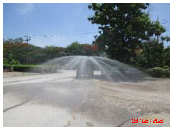
รูปที่ 2-6 การฉีดพรมน้ำบริเวณโรงโม่หิน และเส้นทางลำเลียงหิน
