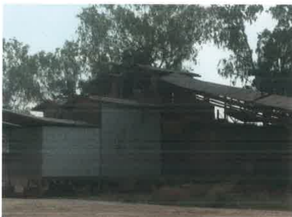
รูปที่ 9 การปิดคลุมอาคาร โรงโม่หินชุด Hopper และ Primary Crusher
