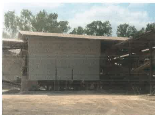
รูปที่ 10 การปิดคลุมอาคาร โรงโม่หิน ชุด Secondary Crusher
