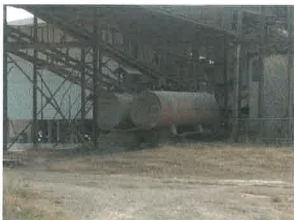
รูปที่ 11 ถังเก็บน้ำสำหรับสเปรย์น้ำในโรงโม่หิน
