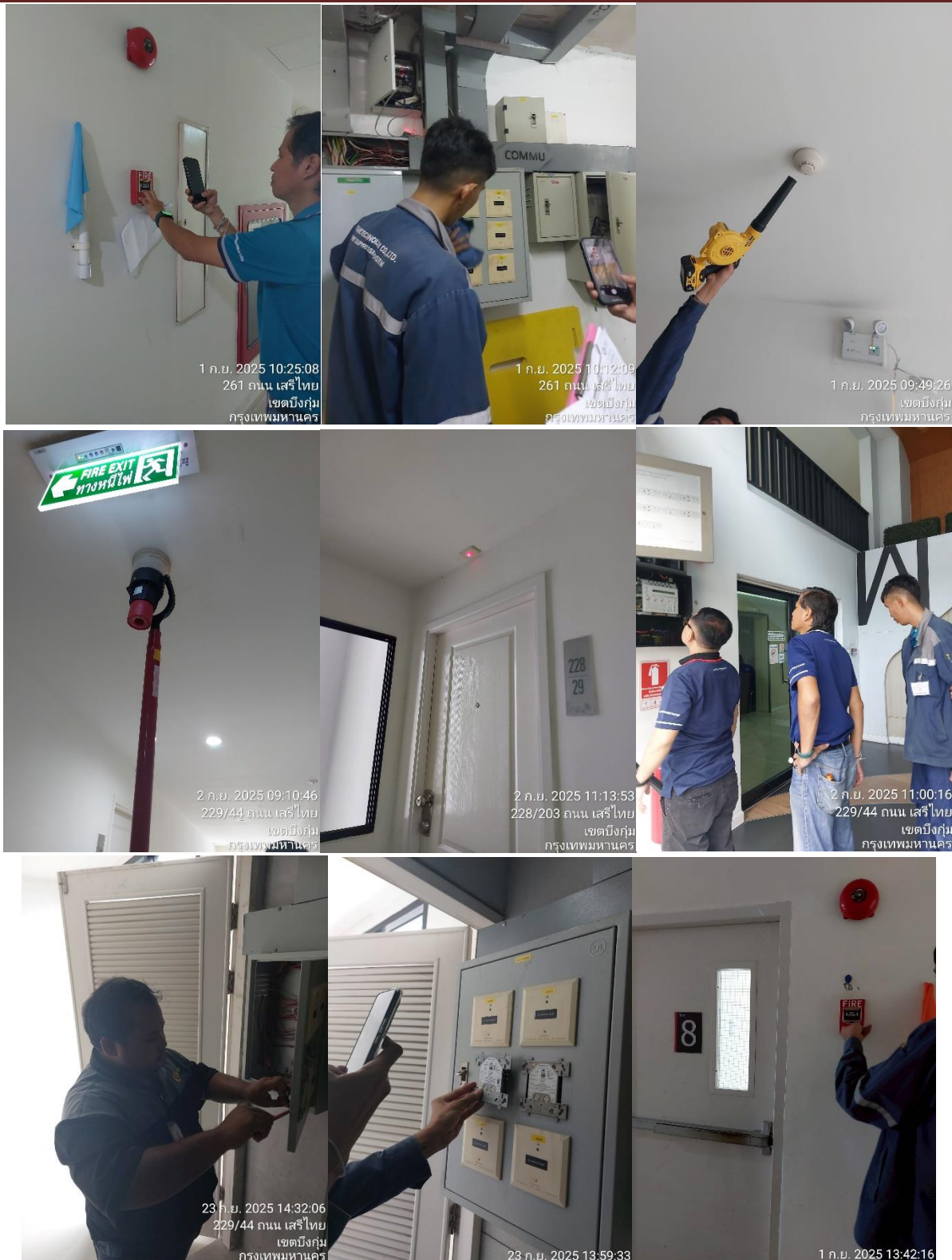
รูปที่ 7 การตรวจเช็คอุปกรณ์ป้องกันอัคคีภัย และการบำรุงรักษาอุปกรณ์และสัญญาณแจ้งเหตุเพลิงไหม้ ของพื้นที่ส่วนกลางทั้งภายในและภายนอกอาคาร ประจำปี 2568
