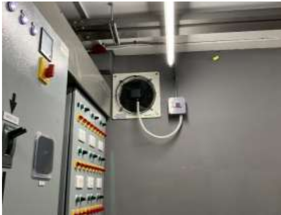
พัดลมระบายอากาศในห้อง MDB
