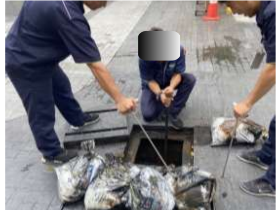
ภาพที่ 2-23 เจ้าหน้าที่ลอกท่อระบายน้ำ
