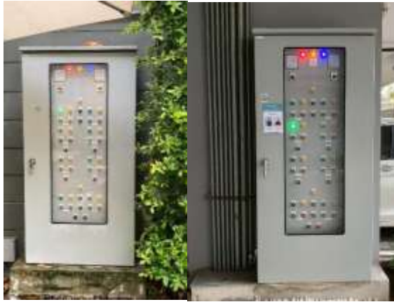
ตู้ Control ของระบบบำบัดน้ำเสียอาคาร A , B
