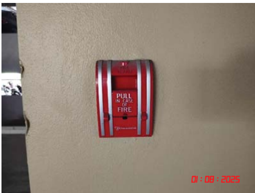
ระบบสัญญาณเตือนภัยแบบใช้มือกด
