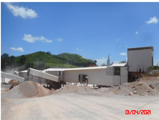
รูปที่ 2-12 อาคารปิดคลุมโรงโม่หิน 3 ด้าน
