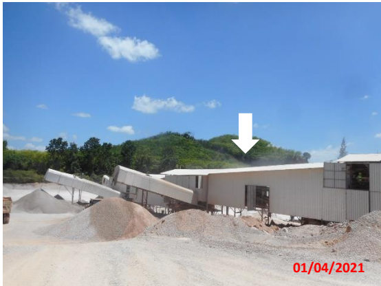
รูปที่ 2-5 อาคารปิดคลุมโรงโม่หิน 3 ด้าน
