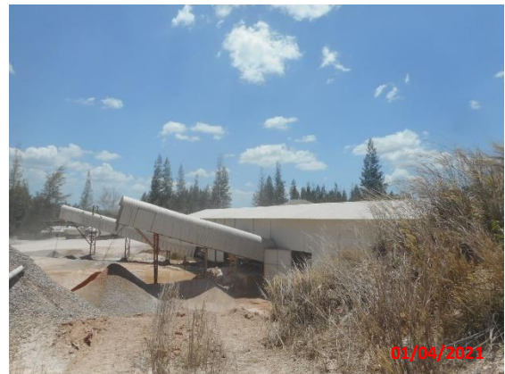
รูปที่ 2-6 อาคารปิดคลุมสายพานลำเลียง
