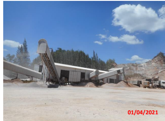
รูปที่ 2-5 อาคารปิดคลุมโรงโม่หิน 3 ด้าน
