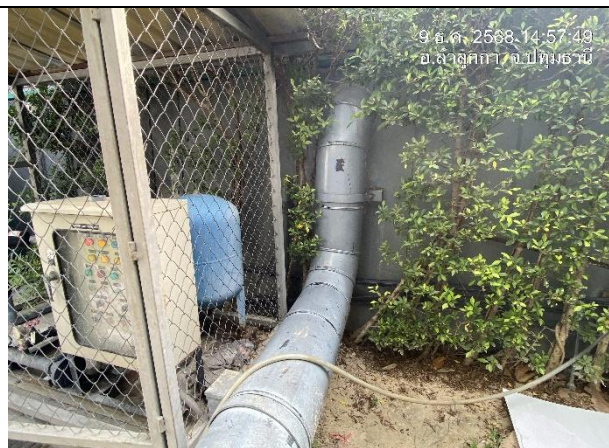
รูปที่ 2-18 เครื่องสูบน้ำเพื่อระบายน้ำฝน
