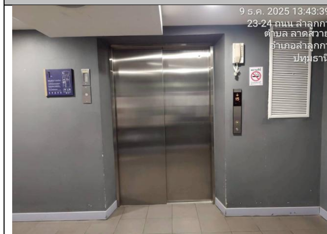
รูปที่ 2-52 ลิฟต์ดับเพลิงสำหรับเส้นทางอพยพผู้ป่วยที่ช่วยเหลือตัวเองไม่ได้ไปยังจุดรวมพล
