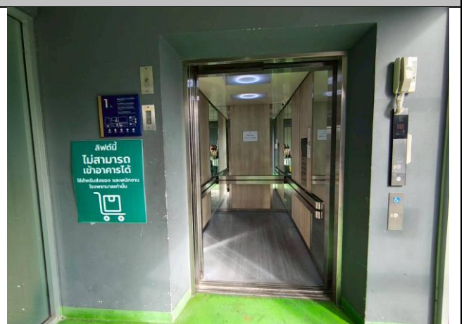
รูปที่ 2-52 ลิฟต์ดับเพลิงสำหรับเส้นทางอพยพผู้ป่วยที่ช่วยเหลือตัวเองไม่ได้ไปยังจุดรวมพล
