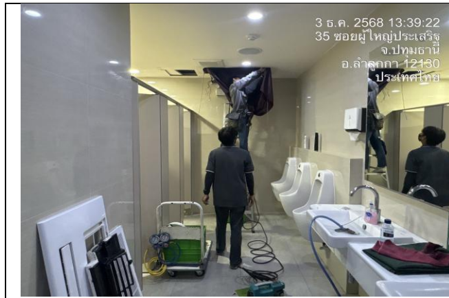
รูปที่ 2-43 การล้างทำความสะอาดระบบปรับอากาศภายในโครงการ (ต่อ)
