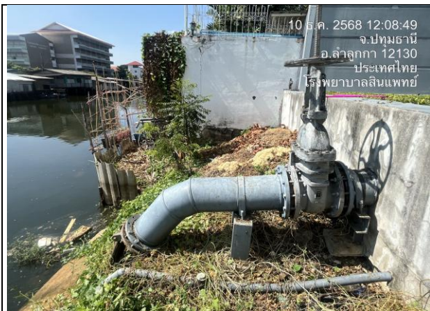
รูปที่ 2-18 เครื่องสูบน้ำเพื่อระบายน้ำฝน
