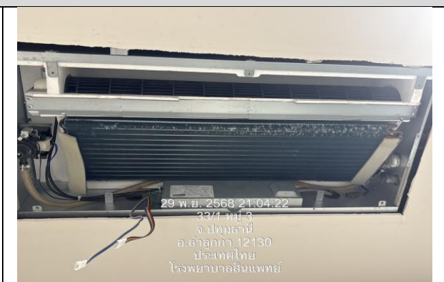
รูปที่ 2-43 การล้างทำความสะอาดระบบปรับอากาศภายในโครงการ
