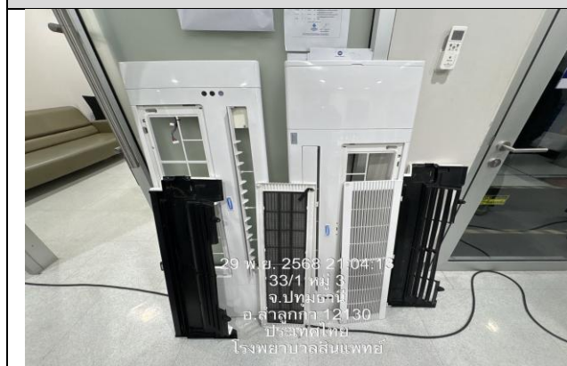
รูปที่ 2-43 การล้างทำความสะอาดระบบปรับอากาศภายในโครงการ
