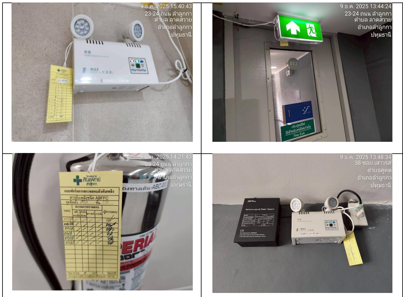
รูปที่ 3-20 การตรวจสอบอุปกรณ์ระบบป้องกันอัคคีภัย
