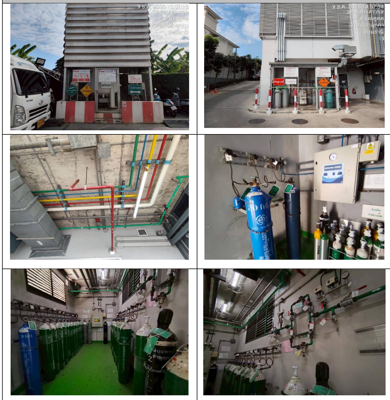
รูปที่ 2-55 การติดตั้งระบบก๊าซทางการแพทย์
