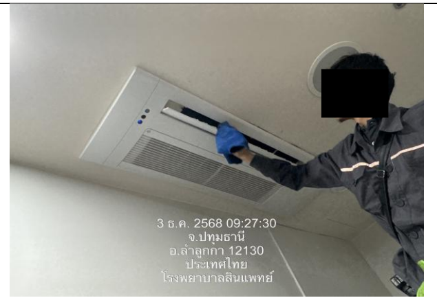
รูปที่ 2-43 การล้างทำความสะอาดระบบปรับอากาศภายในโครงการ (ต่อ)
