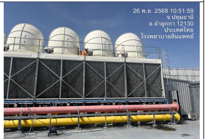
รูปที่ 2-45 การตรวจสอบและการทำความสะอาดหึ่งเย็น
