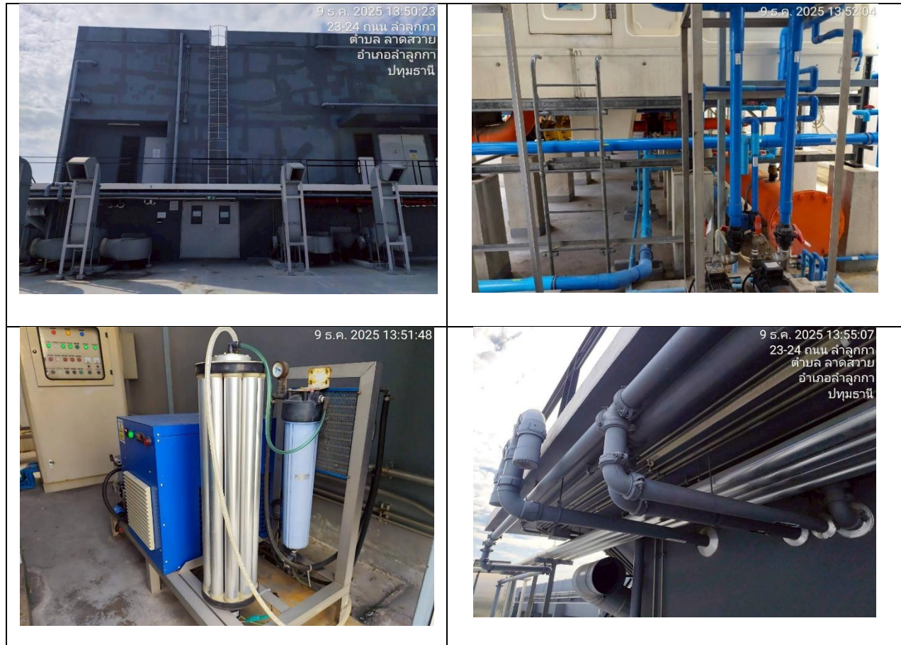
รูปที่ 2-13 ระบบจ่ายน้ำ ถังน้ำสำรอง และระบบเส้นท่อประปา ในบริเวณโครงการ
