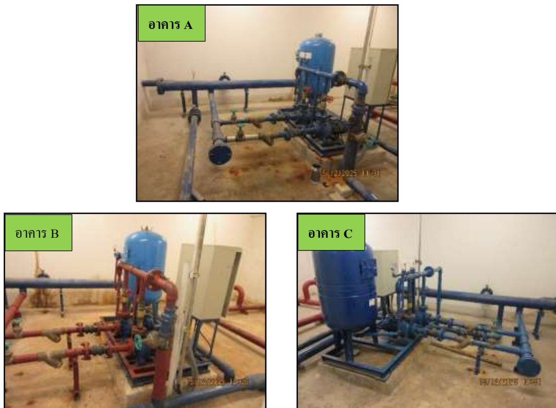
รูปที่ 40 ระบบเครื่องปั้มน้ำใช้ภายในอาคาร
