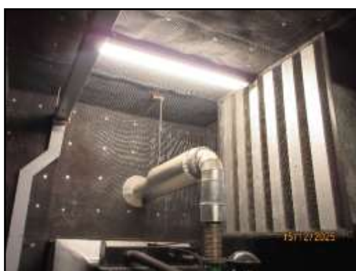
รูปที่ 16 ฉนวนกันเสียง ช่องระบายอากาศ และท่อกำจัดไอเสีย
