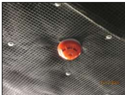
รูปที่ 69 อุปกรณ์ตรวจจับความร้อน
