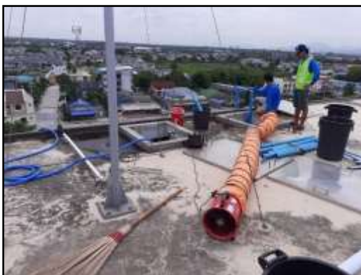
รูปที่ 44 (ต่อ) การล้างทำความสะอาดถังเก็บน้ำสำรองของโครงการ
