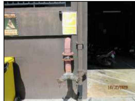
รูปที่ 76 ท่อรับน้ำดับเพลิงประจำอาคาร
