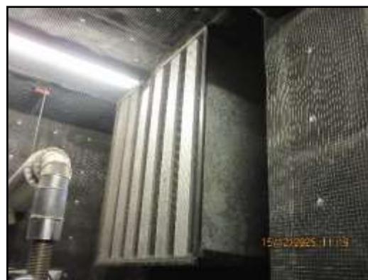
รูปที่ 16 (ต่อ) ฉนวนกันเสียง ช่องระบายอากาศ และท่อกำจัดไอเสีย
