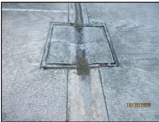
รูปที่ 80 ท่อระบายน้ำรอบโครงการ และบ่อดักขยะบริเวณจุดเชื่อมต่อของโครงการ
