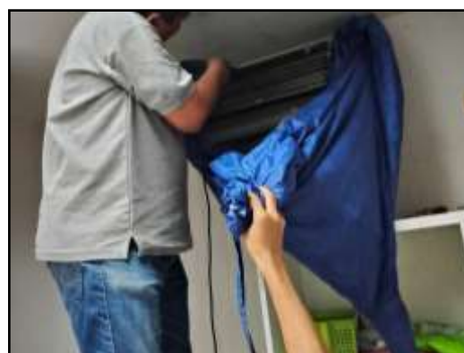
รูปที่ 7 เจ้าหน้าที่ล้างทำความสะอาดเครื่องปรับอากาศ
