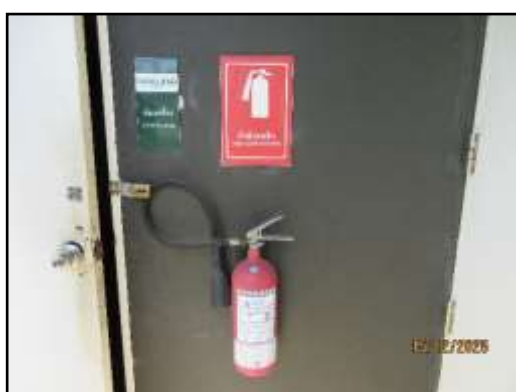
รูปที่ 72 ตู้เก็บสายฉีดน้ำดับเพลิงพร้อมอุปกรณ์ ถังดับเพลิงแบบมือถือพร้อมป้ายแนะนำการใช้ อุปกรณ์
