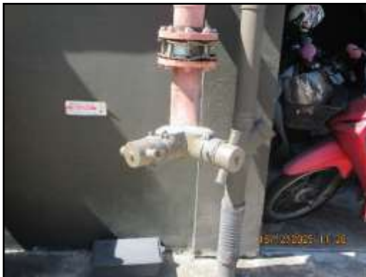
รูปที่ 76 ท่อรับน้ำดับเพลิงประจำอาคาร
