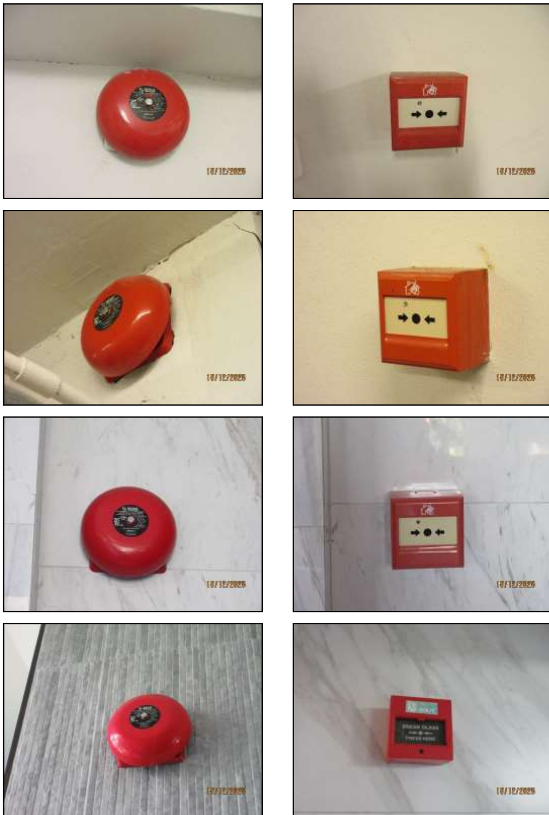
รูปที่ 70 เครื่องแจ้งเหตุโดยใช้มือดึง และกริ่งสัญญาณเตือนภัย
