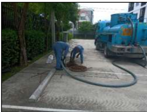
รูปที่ 22 สูบกากตะกอน
