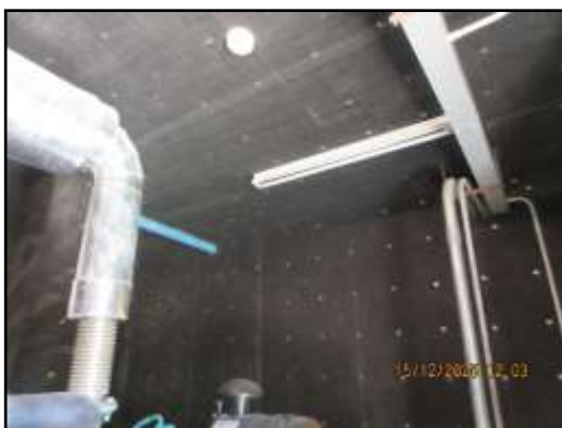
รูปที่ 16 (ต่อ) ฉนวนกันเสียง ช่องระบายอากาศ และท่อกำจัดไอเสีย
