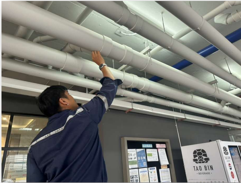
ภาพที่ 11 : ช่างอาคารตรวจสอบการแตกหรือรั่วซึมของท่อประปา
