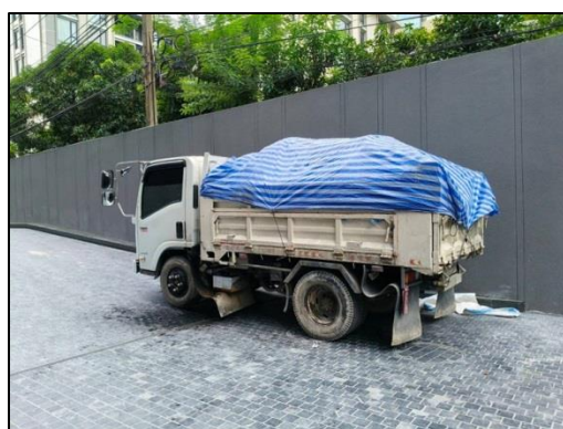
รูปที่ 4 ผ้าใบปิดคลุมกองวัสดุหรือเศษวัสดุที่เหลือ และการขนย้ายวัสดุออกจากพื้นที่ก่อสร้าง
