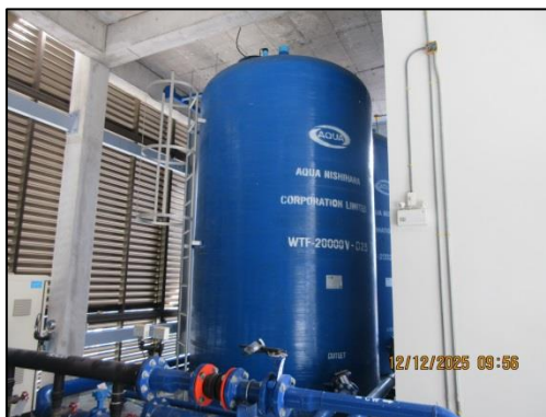
รูปที่ 14 ถังเก็บน้ำสำรอง
