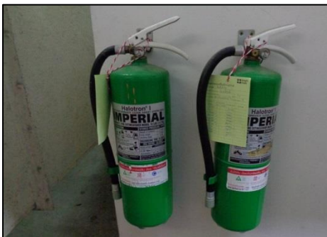
รูปที่ 31 ถังดับเพลิงชนิดน้ำยาเหลวระเหย บีเอฟ 2000
