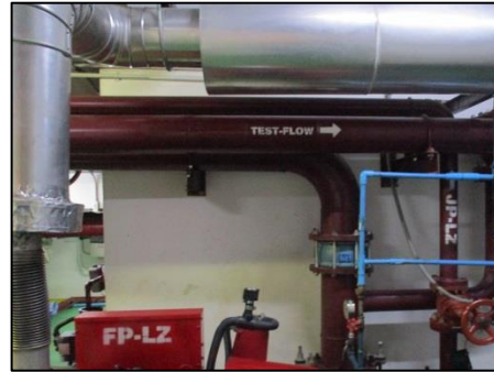
รูปที่ 27 ระบบท่อเย็น ใช้ท่อเย็นที่มีขนาดเส้นผ่านศูนย์กลาง 6 นิ้ว สำหรับพื้นที่ Low Zone และ High Zone
