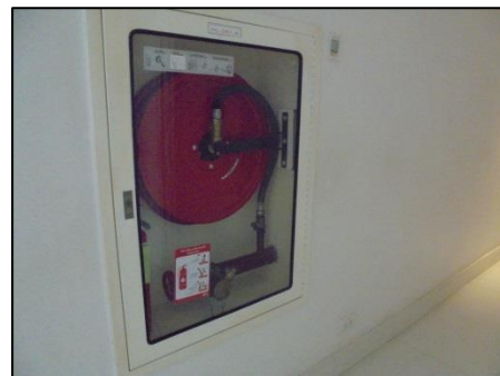
รูปที่ 28 ตู้เก็บสายฉีดน้ำดับเพลิงพร้อมอุปกรณ์ (FHC)
