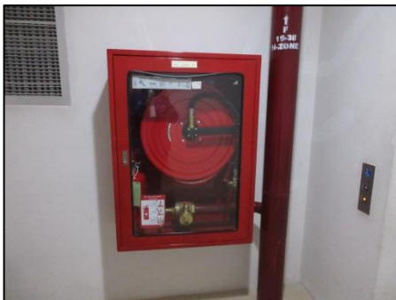
รูปที่ 27 ระบบท่อเย็น ใช้ท่อเย็นที่มีขนาดเส้นผ่านศูนย์กลาง 6 นิ้ว สำหรับพื้นที่ Low Zone และ High Zone
