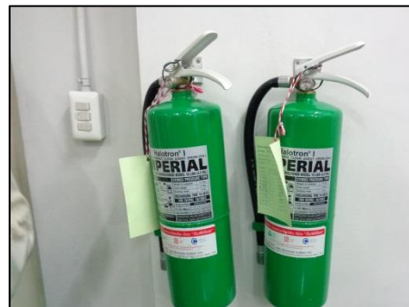
รูปที่ 31 ถังดับเพลิงชนิดน้ำยาเหลวระเหย บีเอฟ 2000
