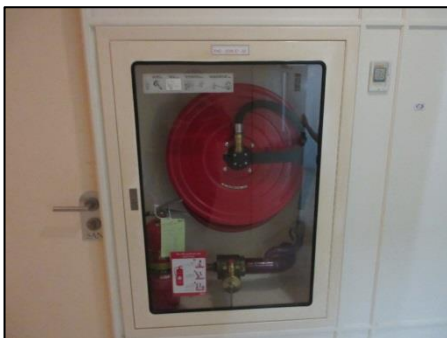
รูปที่ 28 ตู้เก็บสายฉีดน้ำดับเพลิงพร้อมอุปกรณ์ (FHC)
