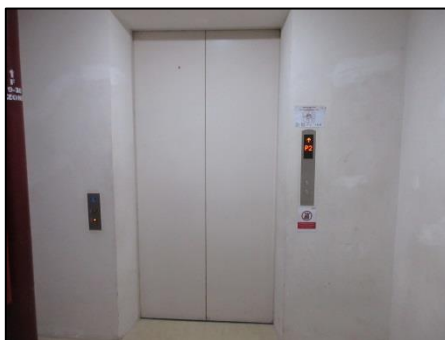
รูปที่ 32 ลิฟต์ดับเพลิงของอาคารชุดคิวหลังสวน
