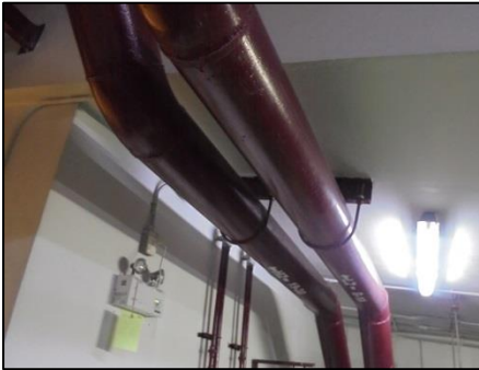
รูปที่ 27 ระบบท่อเย็น ใช้ท่อเย็นที่มีขนาดเส้นผ่านศูนย์กลาง 6 นิ้ว สำหรับพื้นที่ Low Zone และ High Zone
