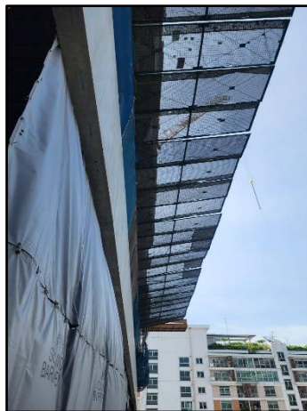
รูปที่ 20 ตาข่ายดักป้องกันวัสดุตกหล่นโดยรอบอาคาร
