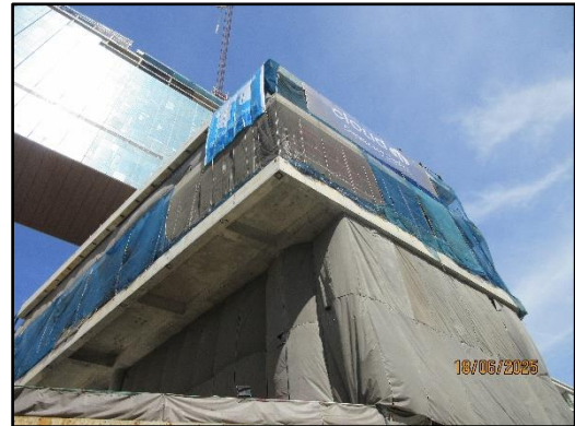
รูปที่ 19 Mesh Sheet (ชนิดกันไฟลาม) ตั้งแต่ชั้นล่างจนถึงชั้นสูงสุดโดยรอบอาคาร
