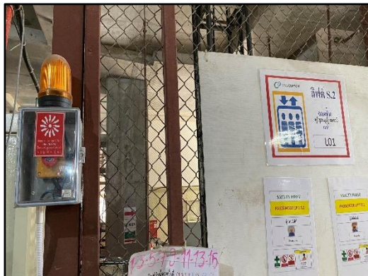
รูปที่ 74 เครื่องแจ้งเหตุเตือนเพลิงไหม้ด้วยกระดิ่งแจ้งเหตุเพลิงไหม้ (Alarm Bell)
