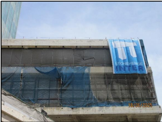
รูปที่ 19 Mesh Sheet (ชนิดกันไฟลาม) ตั้งแต่ชั้นล่างจนถึงชั้นสูงสุดโดยรอบอาคาร
