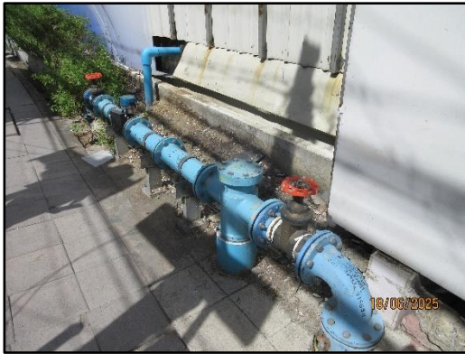
รูปที่ 122 ระบบท่อประปาที่มีสภาพพร้อมใช้งาน
