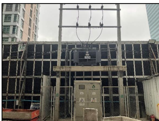
รูปที่ 66 การติดตั้งหม้อแปลงไฟฟ้าแยกจากชุมชน
