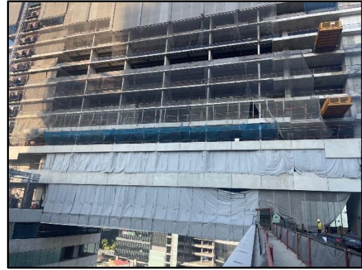
รูปที่ 19 Mesh Sheet (ชนิดกันไฟลาม) ตั้งแต่ชั้นล่างจนถึงชั้นสูงสุดโดยรอบอาคาร
