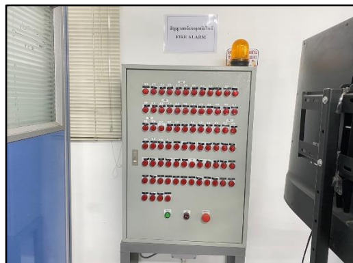
รูปที่ 74 เครื่องแจ้งเหตุเตือนเพลิงไหม้ด้วยกระดิ่งแจ้งเหตุเพลิงไหม้ (Alarm Bell)
