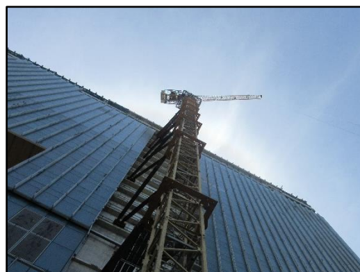
รูปที่ 91 ควบคุมการกวาดแขนของเครนให้อยู่พื้นที่โครงการ
