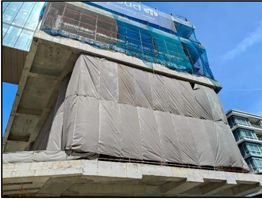
รูปที่ 19 Mesh Sheet (ชนิดกันไฟลาม) ตั้งแต่ชั้นล่างจนถึงชั้นสูงสุดโดยรอบอาคาร
