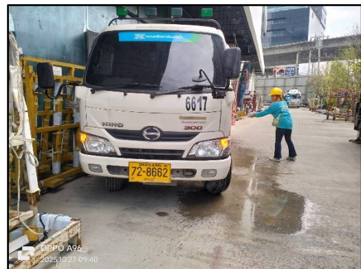
รูปที่ 28 พื้นที่สำหรับทำความสะอาดล้อรถบรรทุก
