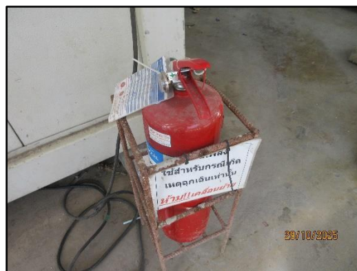
รูปที่ 58 การติดตั้งถังดับเพลิง และการตรวจเช็คสภาพความพร้อมการใช้งานของตัวถังดับเพลิง
