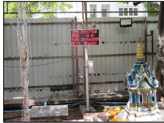
รูปที่ 26 ผลการตรวจวัดบริเวณด้านหน้าโครงการ และติดตั้งเครื่องตรวจวัดฝุ่นแบบเรียลไทม์
