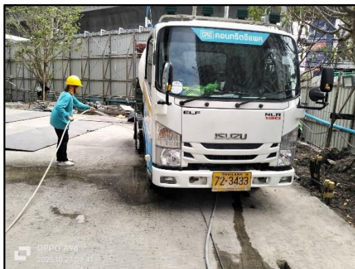
รูปที่ 28 พื้นที่สำหรับทำความสะอาดล้อรถบรรทุก
