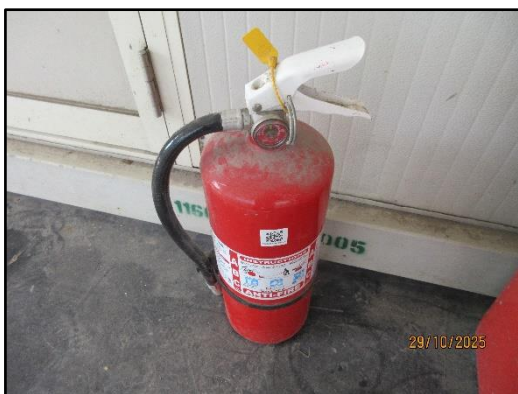
รูปที่ 58 การติดตั้งถังดับเพลิง และการตรวจเช็คสภาพความพร้อมการใช้งานของตัวถังดับเพลิง
