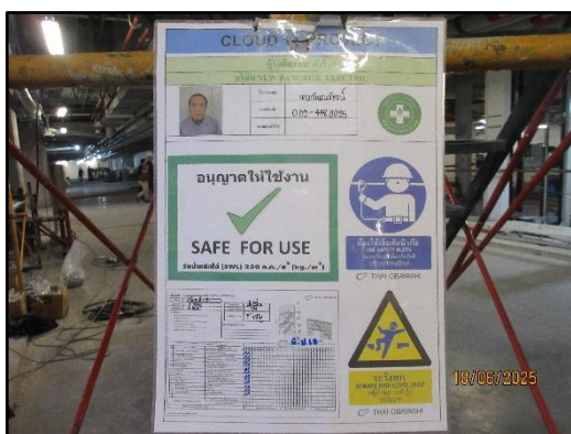
รูปที่ 88 การตรวจสอบความพร้อมของนั่งร้าน
