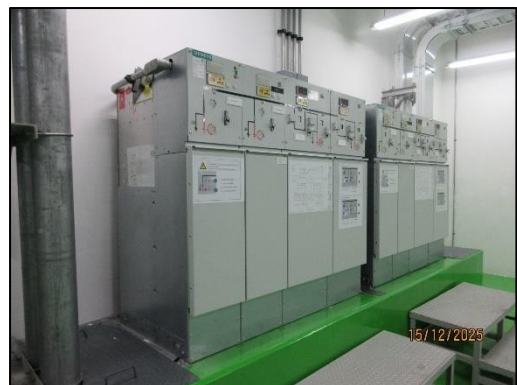
รูปที่ 37 ห้องเครื่องไฟฟ้า (Main Distribution Board: MDB Room)
