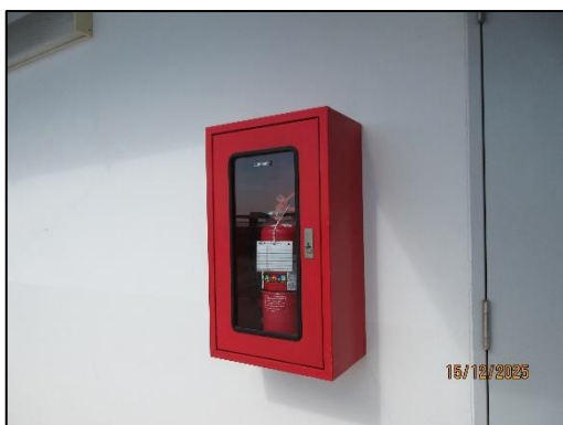
รูปที่ 68 ตู้เก็บสายฉีดน้ำดับเพลิงพร้อมอุปกรณ์ถังดับเพลิงและป้ายวิธีการใช้
