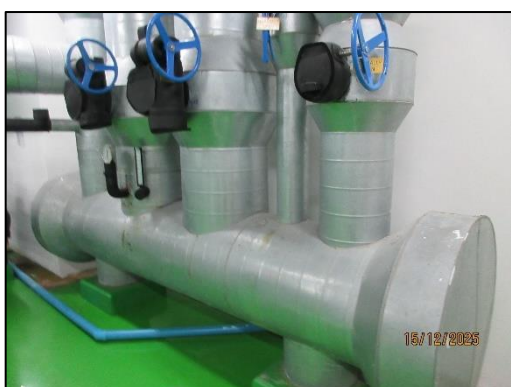
รูปที่ 8 ระบบระบายอากาศแบบจ่ายน้ำจากส่วนกลาง
