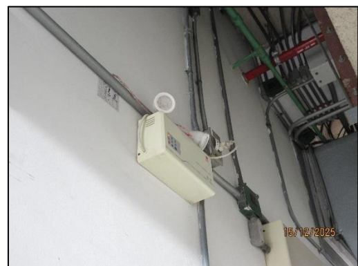
รูปที่ 43 เครื่องไฟฟ้าสำรองและสายไฟ
