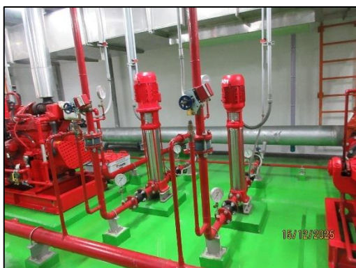
รูปที่ 70 ปั๊มน้ำดับเพลิง (Fire Pump)
