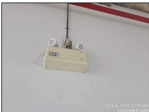
รูปที่ 43 เครื่องไฟฟ้าสำรองและสายไฟ
