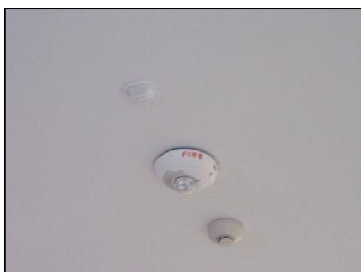
รูปที่ 69 (ต่อ) เครื่องแจ้งเหตุโดยใช่มือ และกริ่งสัญญาณเตือนภัย
