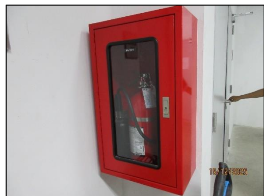
รูปที่ 68 ตู้เก็บสายฉีดน้ำดับเพลิงพร้อมอุปกรณ์ถังดับเพลิงและป้ายวิธีการใช้
