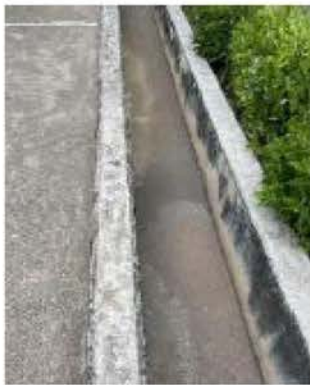
ภาพที่ 2-28 ตัวอย่างรางระบายน้ำเสียและรางระบายน้ำฝนของโรงงาน
