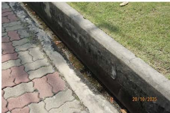
ภาพที่ 2-9 รางระบายน้ำฝนของโครงการ
