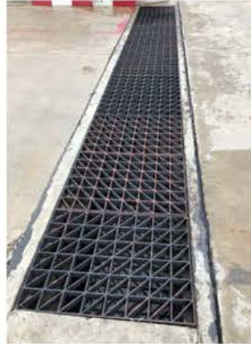
ภาพที่ 2-28 ตัวอย่างรางระบายน้ำเสียและรางระบายน้ำฝนของโรงงาน
