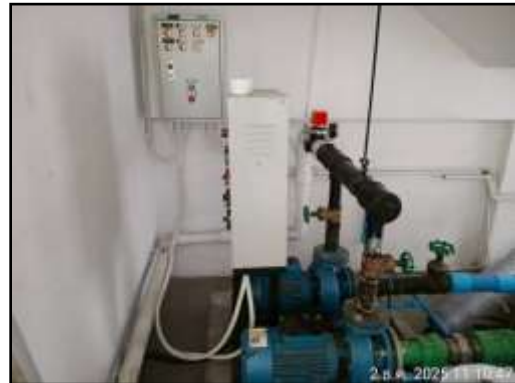
รูปที่ 19 ปัมพ์ดึงเก็บน้ำชั้นใต้ดิน
