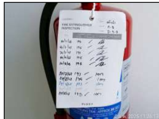
รูปที่ 36 ตรวจสอบถังดับเพลิง
