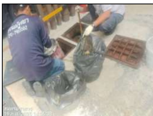
รูปที่ 47 ตักไขมันและตะกอนออกจากระบบบำบัด
