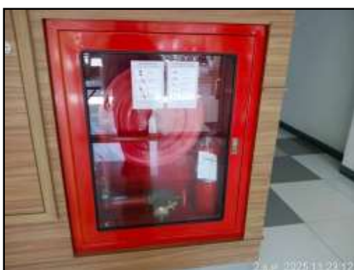
รูปที่ 34 ตู้สายฉีดน้ำดับเพลิง และถังดับเพลิงแบบมือถือ
