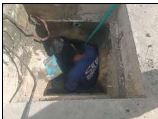
รูปที่ 24 ทำความสะอาดขุดล้างทำความสะอาดระบบระบายน้ำทิ้ง
