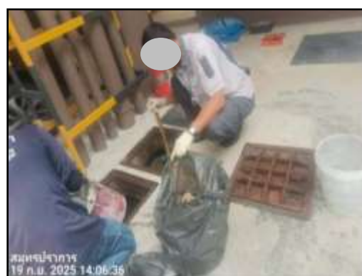
รูปที่ 47 ตักไขมันและตะกอนออกจากระบบบำบัด
