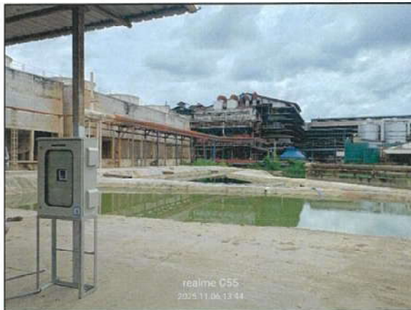
เครื่องตรวจวัดคุณภาพน้ำทิ้งอัตโนมัติ (pH, TDS และอุณหภูมิ) บริเวณระบบบำบัดน้ำเสียความสกปรกต่ำ (Low BOD)
