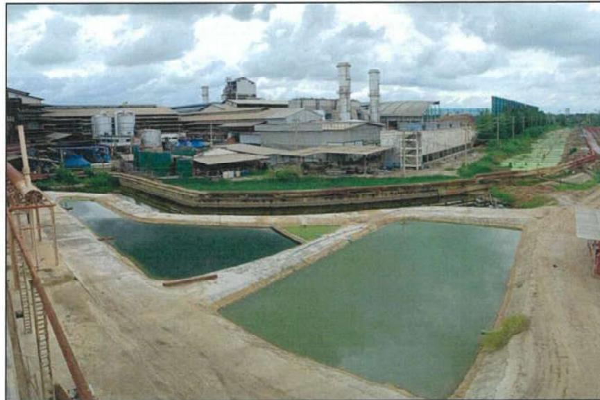
บ่อปรับสภาพน้ำเสียขนาด ๒,๐๐๐ ลูกบาศก์เมตรและบ่อตรวจสอบสภาพน้ำทิ้งขนาด ๕๐ ลูกบาศก์เมตร
