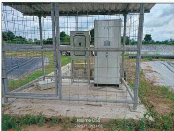
เครื่องตรวจวัดคุณภาพน้ำทิ้งอัตโนมัติ (pH, TDS, BOD/COD) บริเวณบ่อตรวจสอบคุณภาพน้ำทิ้ง (Inspection pond) ขนาด ๓๐ ลูกบาศก์เมตร ของระบบบำบัดน้ำเสียความสกปรกสูง (High BOD)
