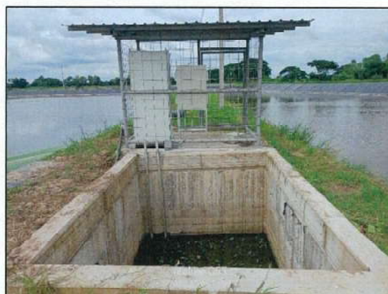
เครื่องตรวจวัดคุณภาพน้ำทิ้งอัตโนมัติ (pH, TDS, BOD/COD) บริเวณบ่อตรวจสอบคุณภาพน้ำทิ้ง (Inspection pond) ขนาด ๓๐ ลูกบาศก์เมตร ของระบบบำบัดน้ำเสียความสกปรกสูง (High BOD)
