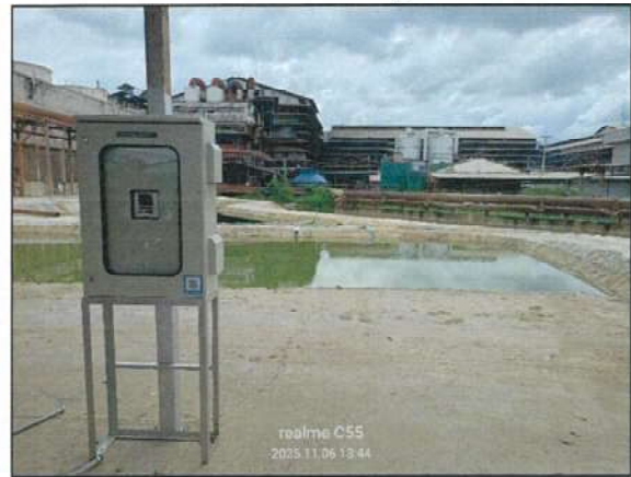
เครื่องตรวจวัดคุณภาพน้ำทิ้งอัตโนมัติ (pH, TDS และอุณหภูมิ) บริเวณระบบบำบัดน้ำเสียความสกปรกต่ำ (Low BOD)
