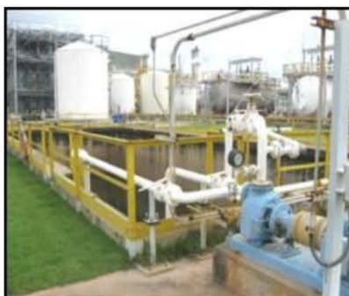
ภาพที่ 2.2-20 ลานถัง และบ่อร์รับสารเคมีหากเกิดการรั่วไหล
