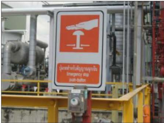
ภาพที่ 2.2-21 ปุ่มกดแจ้งเหตุสัญญาณฉุกเฉิน
