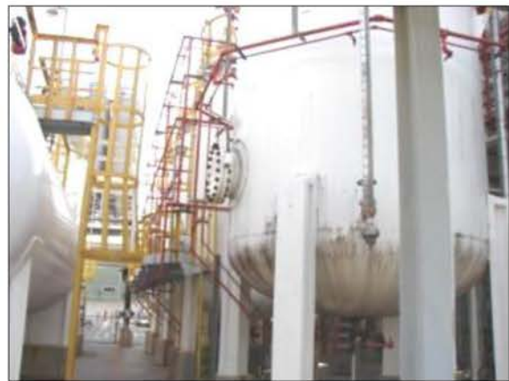
ระบบดับเพลิง Deluge System ในพื้นที่เก็บสารเคมี
