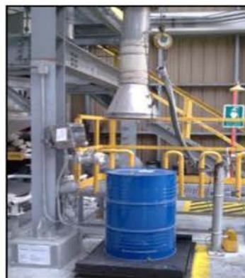
พัฒนาดูดอากาศบริเวณสูบลำสารเคมีจากถัง
