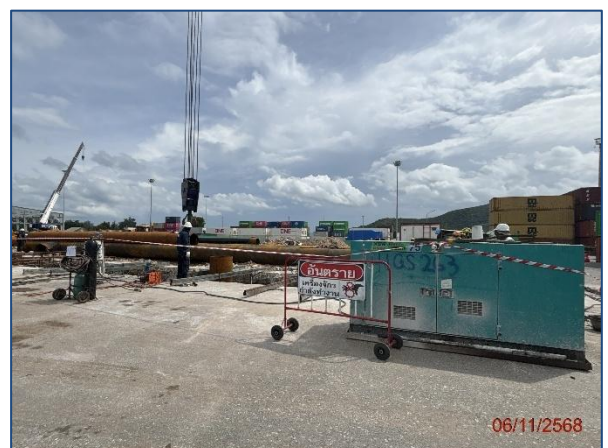
รูปที่ 2.2.1-45 การกั้นพื้นที่ทำงานขณะเครื่องจักรทำงาน
