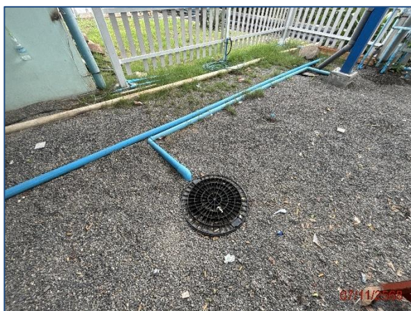
รูปที่ 2.2.2-7 ถังบำบัดสิ่งปฏิกูลจากห้องน้ำ
