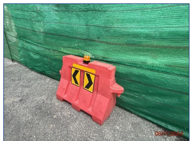
รูปที่ 2.2.1-30 แนวรั้วกัน ไฟกระพริบ ป้ายเตือนอันตราย บริเวณพื้นที่ก่อสร้างหน้าท่า
