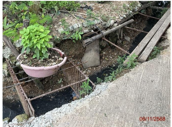
รูปที่ 2.2.1-23 ตะแกรงดักขยะ
