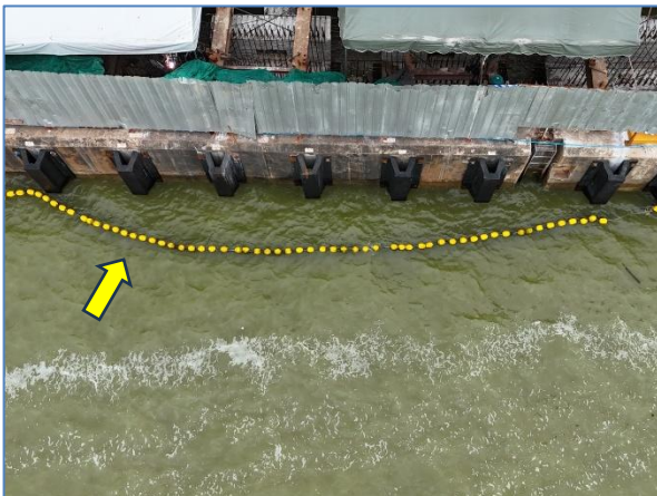
รูปที่ 2.2.1-24 ม่านกันตะกอนบริเวณก่อสร้างปั้นจั่นหน้าท่า
