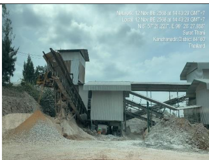
รูป 17 สร้างอาคารปิดคลุม Hopper, Primary Crusher และตระแกรงคัดขนาดแร่ พร้อมทั้งติดตั้งระบบสเปรย์น้ำ
