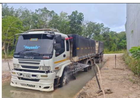
รูป 28 บ่อล้างล้อรถบรรทุกและการล้างล้อรถบรรทุก
