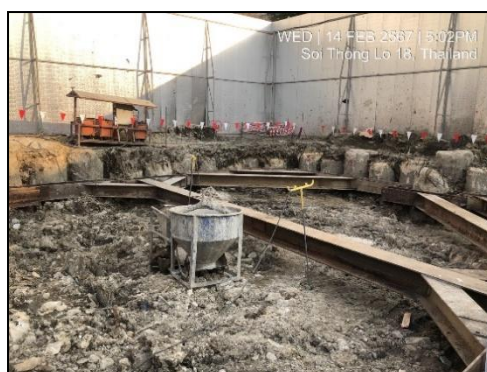
รูปที่ 10 ผนังกันดิน (pile wall)
