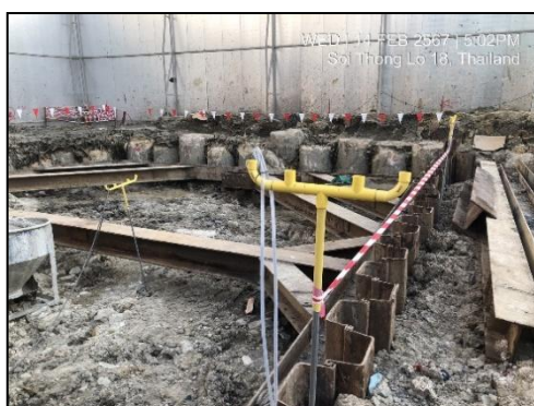
รูปที่ 10 ผนังกันดิน (pile wall)
