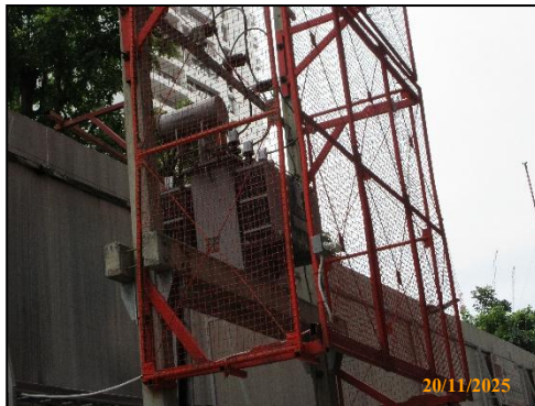
รูปที่ 65 มิเตอร์ไฟฟ้า และหม้อแปลงไฟฟ้าภายในพื้นที่ก่อสร้างโครงการ
