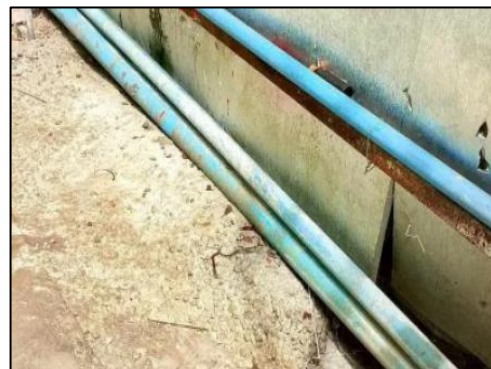
รูปที่ 46 ท่อระบายน้ำชั่วคราวรอบพื้นที่โครงการ
