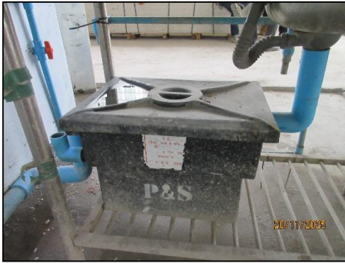
รูปที่ 45 ถังดักไขมัน และระบบบำบัดน้ำเสียแบบสำเร็จรูป ภายในพื้นที่ก่อสร้าง
