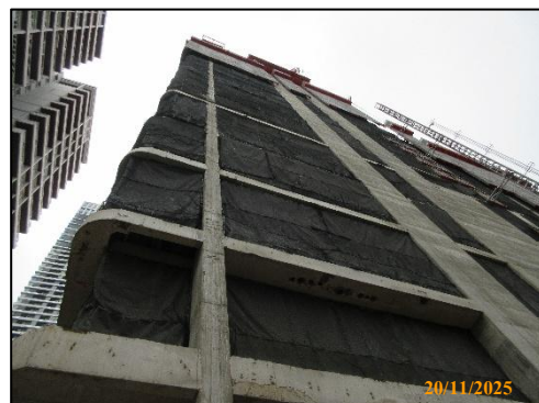
รูปที่ 30 ผ้าใบ (Mesh Sheet) คลุมรอบอาคาร
