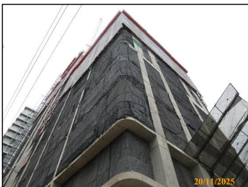
รูปที่ 30 ผ้าใบ (Mesh Sheet) คลุมรอบอาคาร
