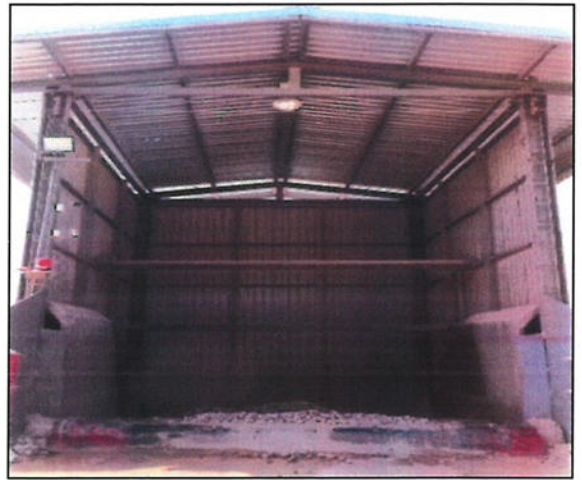
รูปที่ 8 อาคารปิดคลุมโรงโม่หินทั้ง 3 ด้าน
