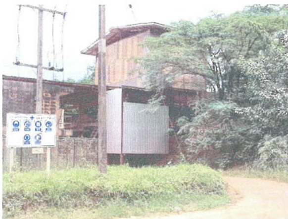
รูปที่ 13 การปิดคลุมอาคารโรงโม่หิน ชุด Hopper และ Primary Crusher
