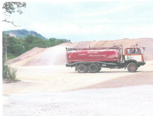
รูปที่ 17 ใช้รถบรรทุกน้ำฉีดพรมภายในบริเวณโรง โม่หินเพื่อลดการฟุ้งกระจายของฝุ่นละออง
