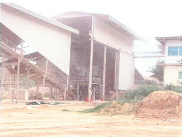
รูปที่ 15 การปิดคลุมอาคารโรงโม่หิน ชุด Secondary & Tertiary Crusher
