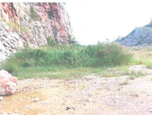
รูปที่ 9 คันทำนบดินแบ่งแนวเขต Buffer Zone กับ พื้นที่ทำเหมือง
