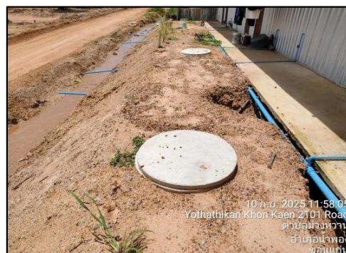
รูปที่ 2-18 ติดตั้งถังเกรอะหรือถังบำบัดน้ำเสียสำเร็จรูป (Septic Tank) บริเวณห้องสุขา
