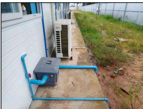
รูปที่ 2-19 ถังดักไขมัน บริเวณพื้นที่สำนักงานก่อสร้าง
