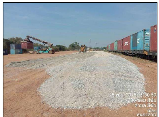
งาน Crushed Rock Base
