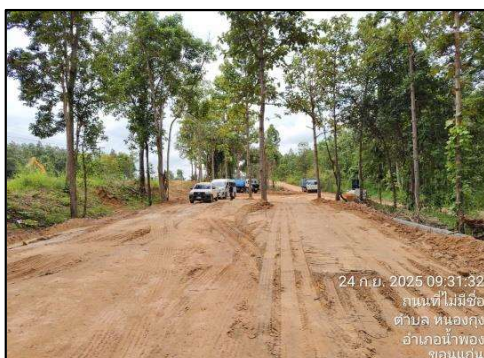
รูปที่ 2-14 จัดทำ Haul Road ใช้ในพื้นที่ก่อสร้าง
