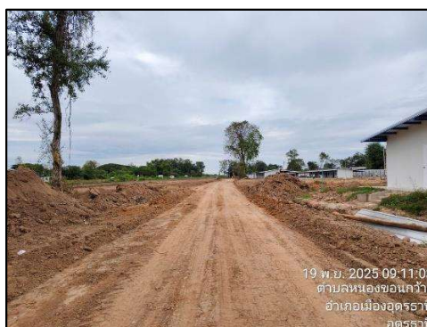
รูปที่ 2-14 (ต่อ) จัดทำ Haul Road ใช้ในพื้นที่ก่อสร้าง
