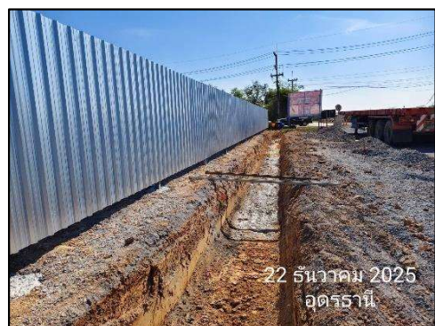
รูปที่ 2-3 ทางระบายน้ำชั่วคราวและบ่อดักตะกอน
