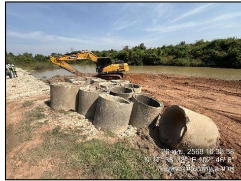
รูปที่ 2-50 การวางท่อบริเวณลำคลองสาธารณะเพื่อให้สามารถไหลผ่านได้ดังเดิม
