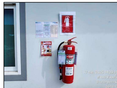
รูปที่ 2-36 ติดตั้งถังดับเพลิงในสำนักงานสนามและบ้านพักคนงาน
