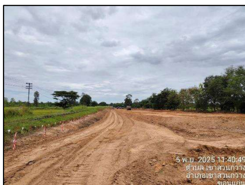
รูปที่ 2-14 (ต่อ) จัดทำ Haul Road ใช้ในพื้นที่ก่อสร้าง
