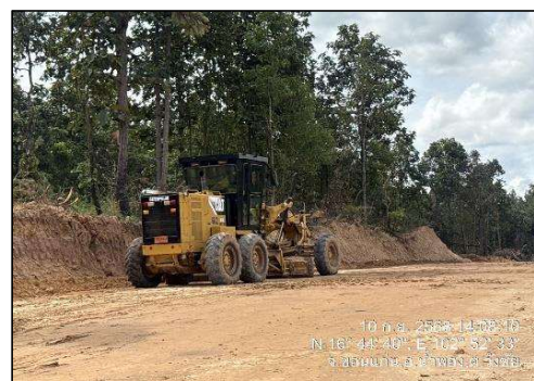
รูปที่ 2-47 การปรับพื้นที่ตามแนวคันทางรถไฟที่มีความลาดชันสูง ให้เป็นแบบขั้นบันไดและบดอัดชั้นดินให้แน่นและราบเรียบสม่ำเสมอ
