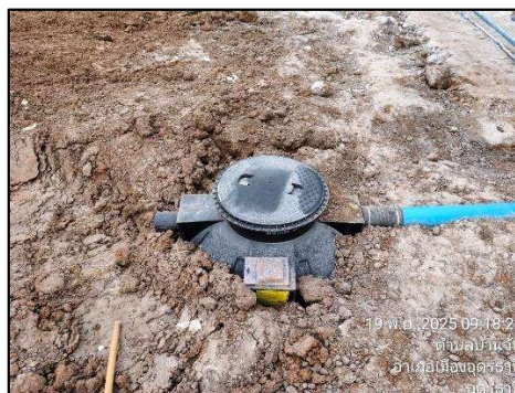
รูปที่ 2-18 (ต่อ) ติดตั้งถังเกรอะหรือถังบำบัดน้ำเสียสำเร็จรูป (Septic Tank) บริเวณห้องสุขา
