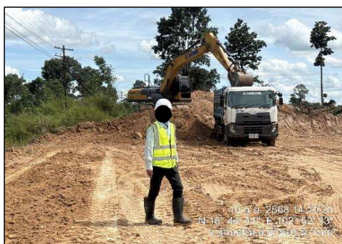
รูปที่ 2-48 การขนย้ายดินจากงานคัดดินคันทางรถไฟบริเวณพื้นที่ลาดชันสูงในช่วงกลางวัน
