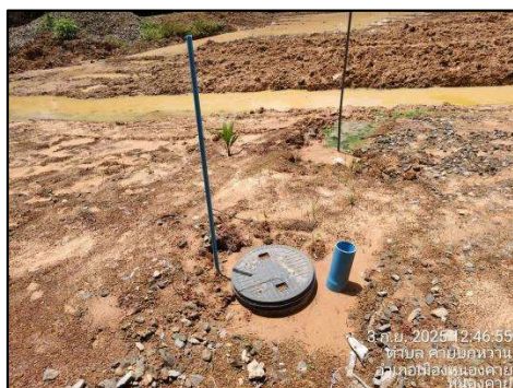
รูปที่ 2-18 ติดตั้งถังเกรอะหรือถังบำบัดน้ำเสียสำเร็จรูป (Septic Tank) บริเวณห้องสุขา
