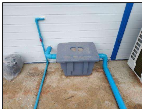
รูปที่ 2-19 ถังดักไขมัน บริเวณพื้นที่สำนักงานก่อสร้าง
