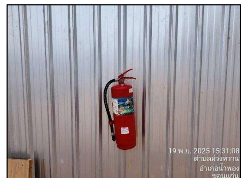
รูปที่ 2-36 ติดตั้งถังดับเพลิงในสำนักงานสนามและบ้านพักคนงาน
