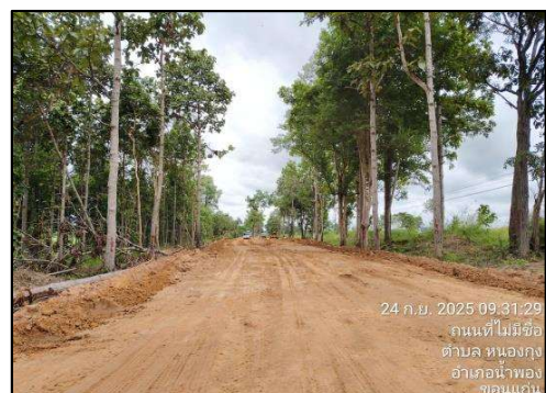
รูปที่ 2-14 จัดทำ Haul Road ใช้ในพื้นที่ก่อสร้าง
