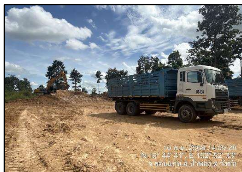
รูปที่ 2-48 การขนย้ายดินจากงานคัดดินคันทางรถไฟบริเวณพื้นที่ลาดชันสูงในช่วงกลางวัน
