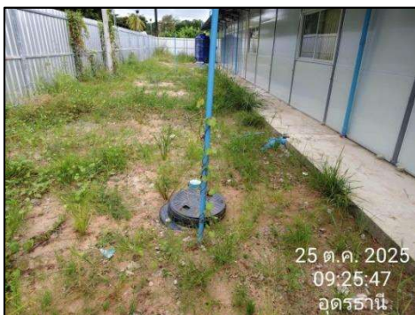
รูปที่ 2-18 (ต่อ) ติดตั้งถังเกรอะหรือถังบำบัดน้ำเสียสำเร็จรูป (Septic Tank) บริเวณห้องสุขา
