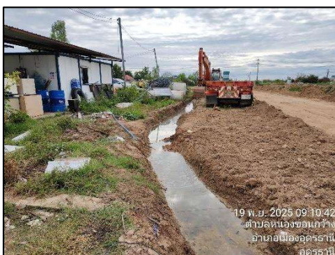
รูปที่ 2-3 ทางระบายน้ำชั่วคราวและบ่อดักตะกอน
