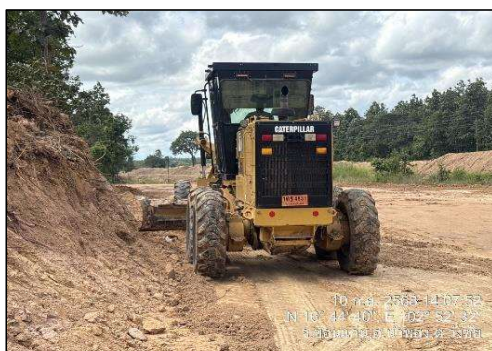
รูปที่ 2-47 การปรับพื้นที่ตามแนวคันทางรถไฟที่มีความลาดชันสูง ให้เป็นแบบขั้นบันไดและบดอัดชั้นดินให้แน่นและราบเรียบสม่ำเสมอ
