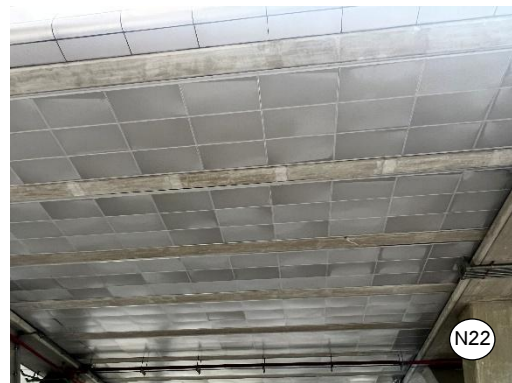
รูปที่ 2-5 วัสดุดูดซับเสียง ช่วงหมอชิต-สะพานใหม่
