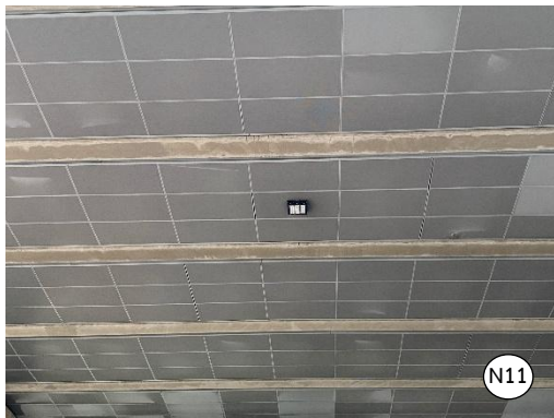
รูปที่ 2-5 วัสดุดูดซับเสียง ช่วงหมอชิต-สะพานใหม่
