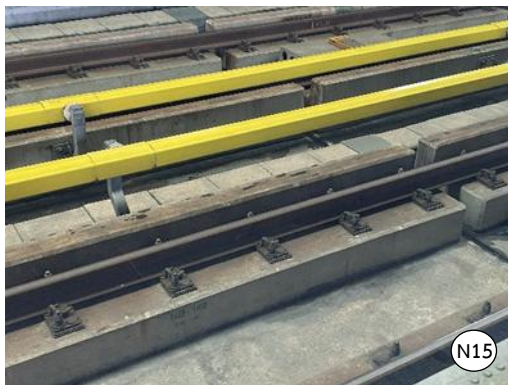
รูปที่ 2-33 หมุดยึดราง เฉพาะช่วงสะพานใหม่-ลำลูกกา คลอง 4
