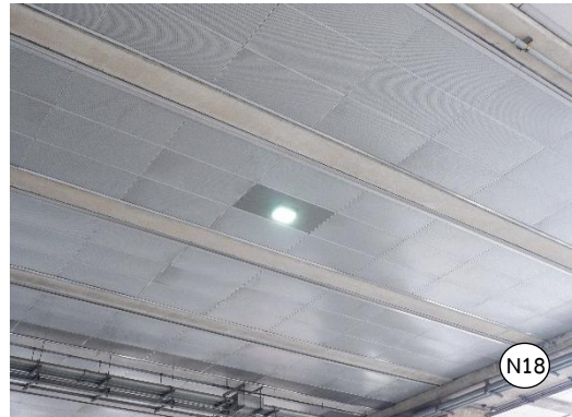
รูปที่ 2-37 ติดตั้งไฟส่องสว่างบริเวณใต้สถานีและด้านข้างริมทางเท้า
