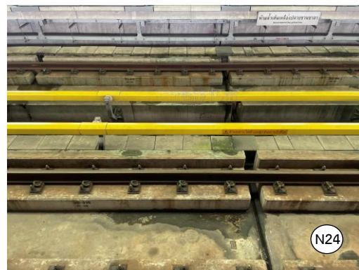
รูปที่ 2-33 หมุดยึดราง เฉพาะช่วงสะพานใหม่-ลำลูกกา คลอง 4
