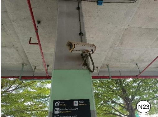
รูปที่ 2-45 โทรศัพท์วงจรปิด (CCTV) บริเวณอาคารจอดและจร
