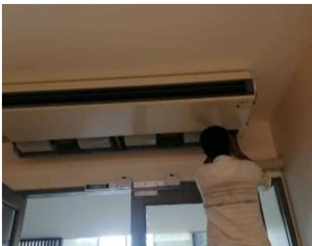
ภาพที่ 2-17 การล้างเครื่องปรับอากาศ
