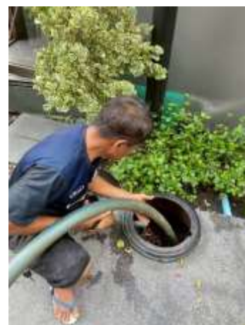
การสูบน้ำก่อนส่วนเกินจากระบบบำบัดน้ำเสีย
