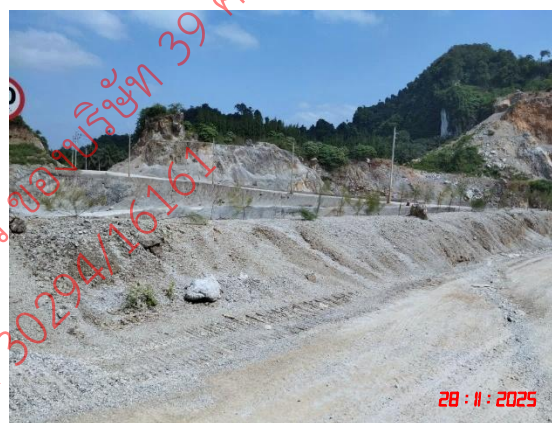
รูปที่ 4 คั่นทำนบดิน และคูระบายน้ำโดยรอบพื้นที่โครงการ
