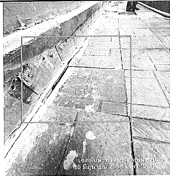
ภาพที่ 30 แผ่นปูทางเดินทรุดและมีรอยแตก
