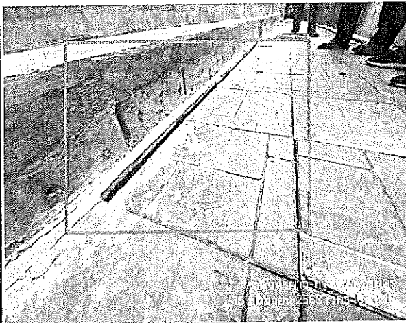
ภาพที่ 29 แผ่นปูทางเดินทรุดและมีรอยแตก
