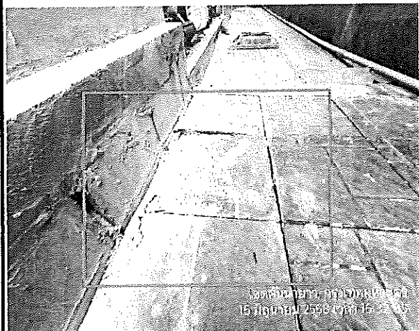
ภาพที่ 32 แผ่นปูทางเดินทรุดและมีรอยแตก
